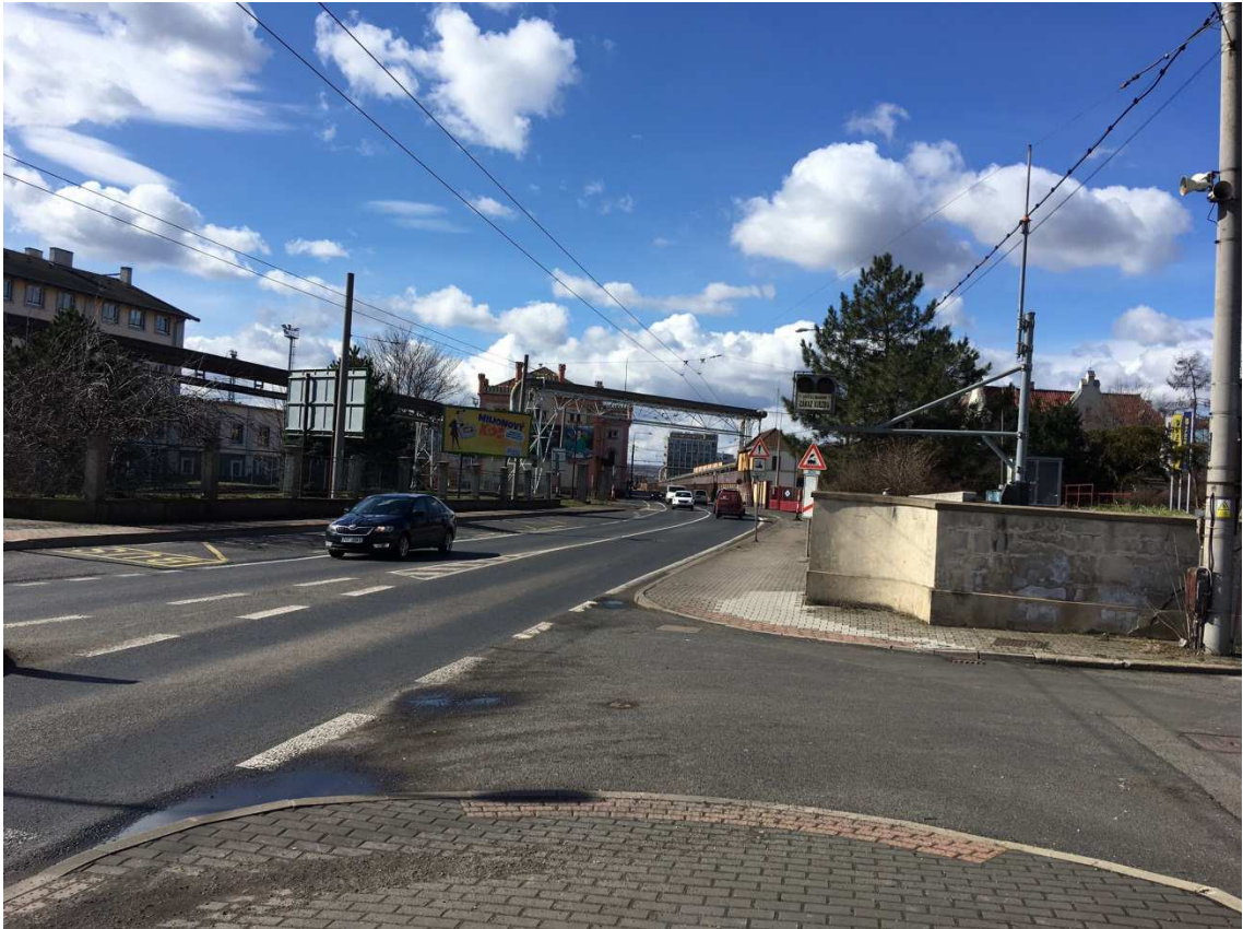
Obrázek 14 – Železniční vlečka Spolchemie, západní pohled [zdroj: vlastní].
