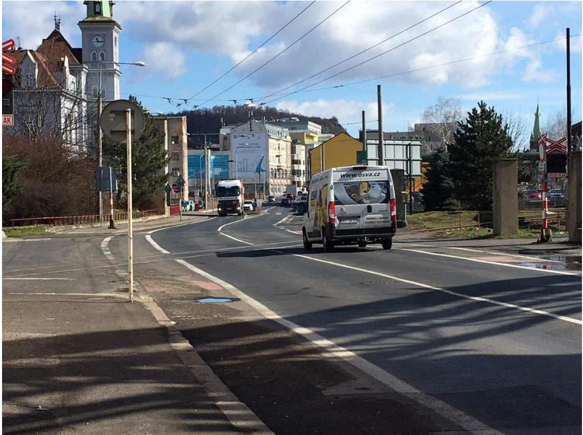
Obrázek 15 - Železniční vlečka východní pohled [zdroj: vlastní].
