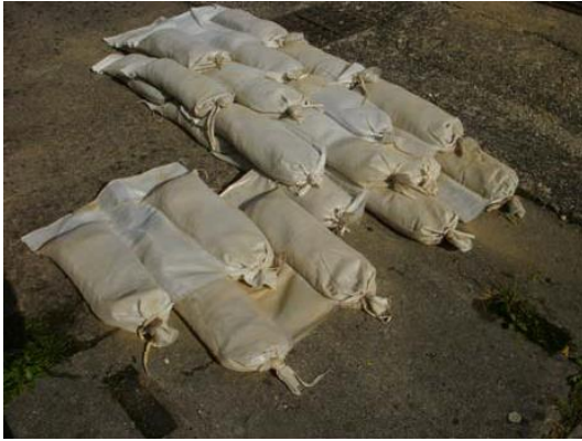
Umístění hráze z dvoukomorových pytlů
