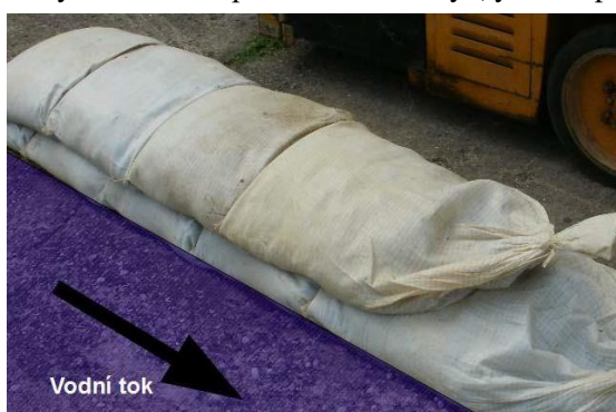
Jednořadé kladení pytlů podélně
