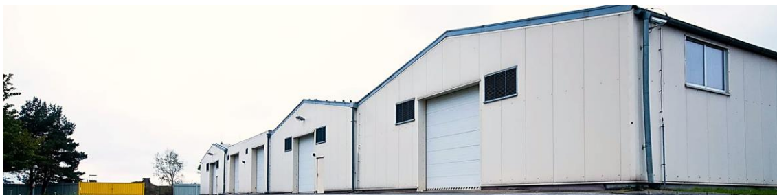
Obrázek 17 – Skladové haly z kazetových profilů (zdroj: https://www.sshr.cz/nabidky-a-zakazky/ )
