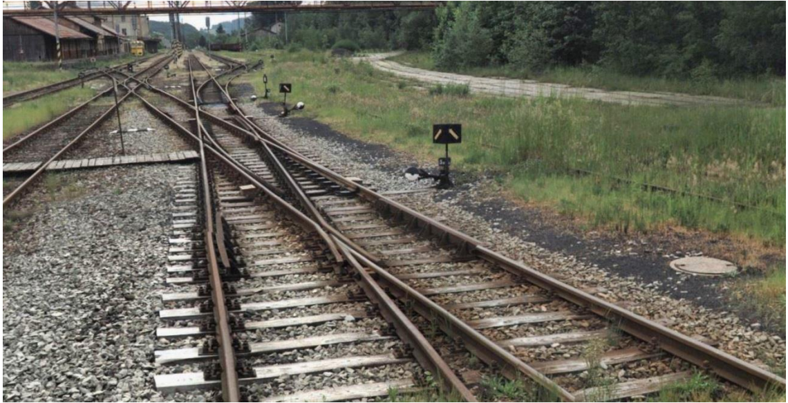
Obrázek 20 - Příklad zajištění kolejové výhybky (zdroj. mapy.cz)
