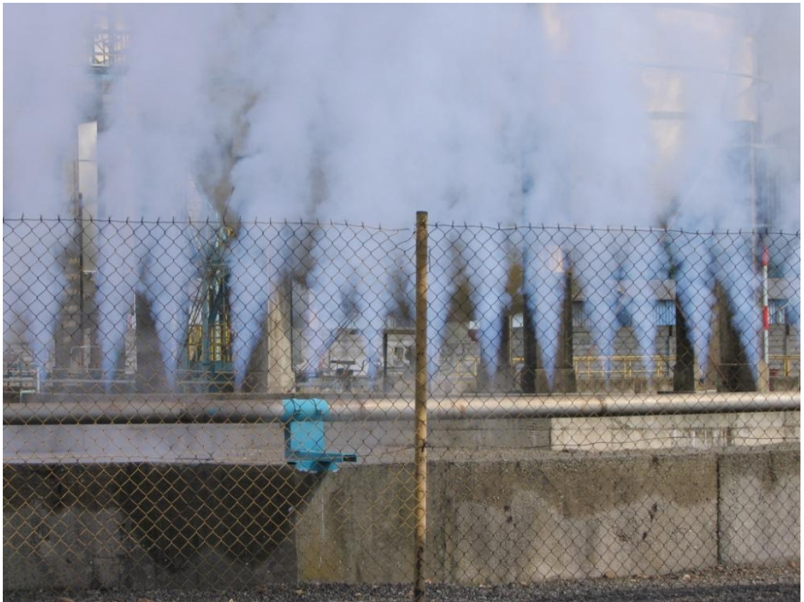
Příloha 3 Spuštěná parní clona (foto autor práce)
