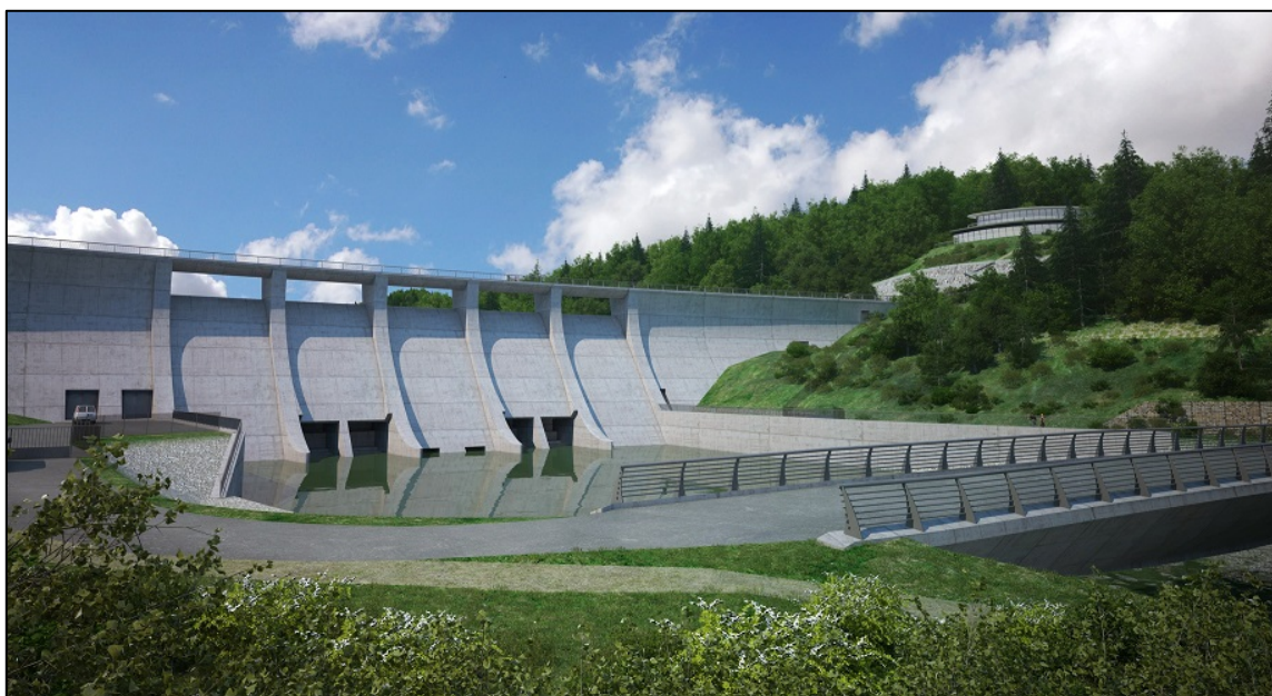
Obrázek 12 Betonová vodní hráz na VD Nové Heřminovy [31]
