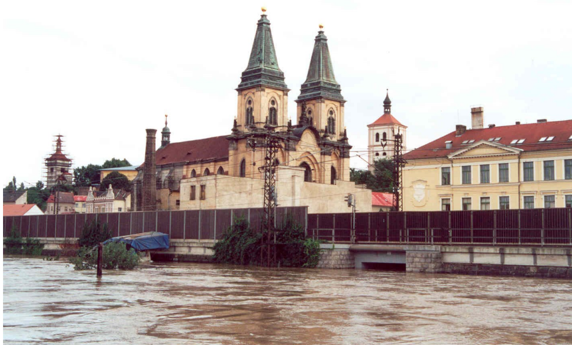
Příloha 3 – Povodně 2002: Nábřežní ulice. [53]
