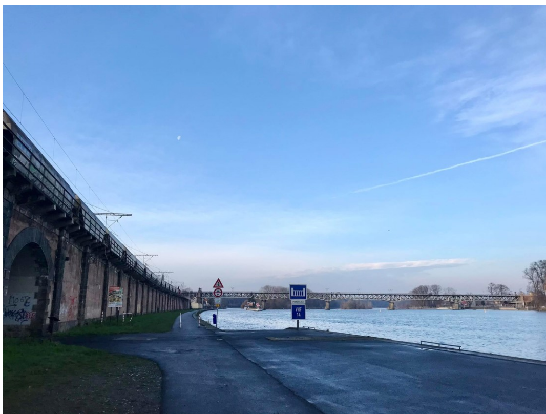
Příloha 8 – Násep železnice na levém břehu řeky Labe
