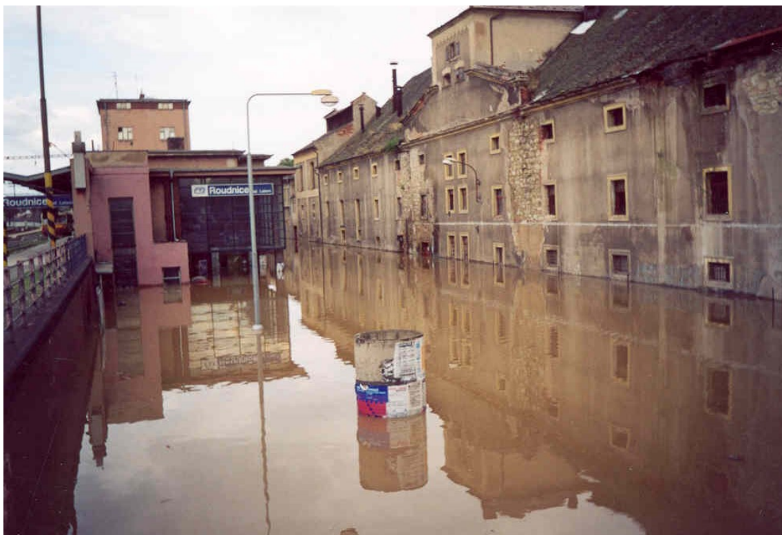
Příloha 2 – Povodně 2002: budova nádraží. [53]
