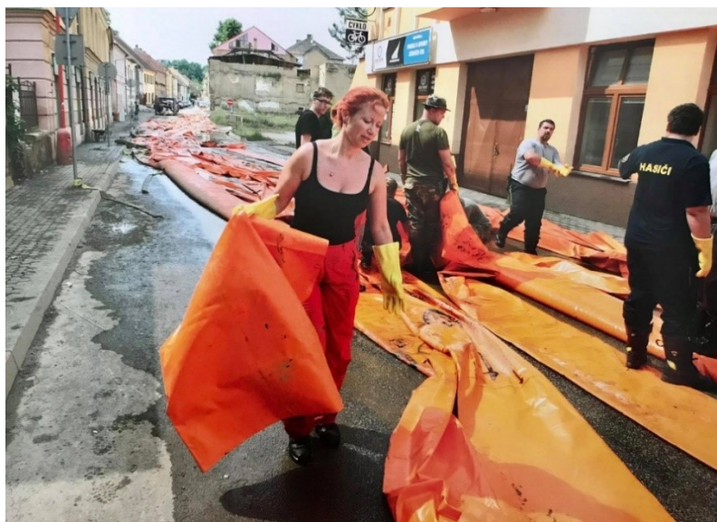
Obrázek 17 – Osazování povodňového profilu v ulici Havlíčkova. [60]
