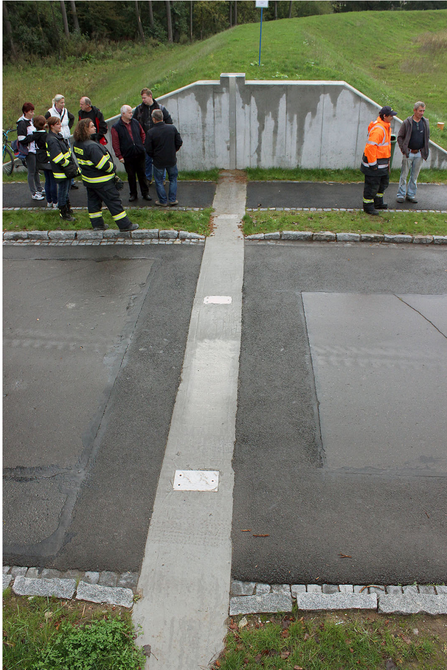
Obrázek 30: Polabec - pohled na protipovodňový val [45]
