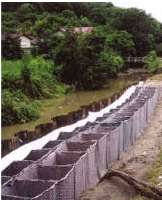
Obrázek 27: Gabionový systém košů [32]
