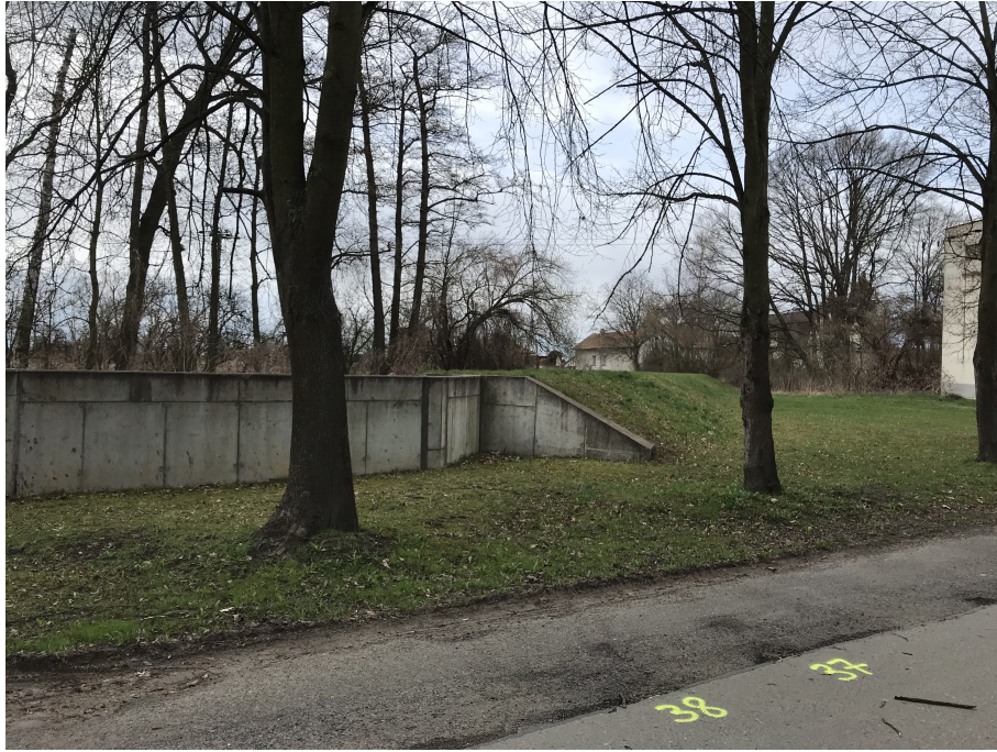
Obrázek 33: Polabec železobetonová zídka a val
