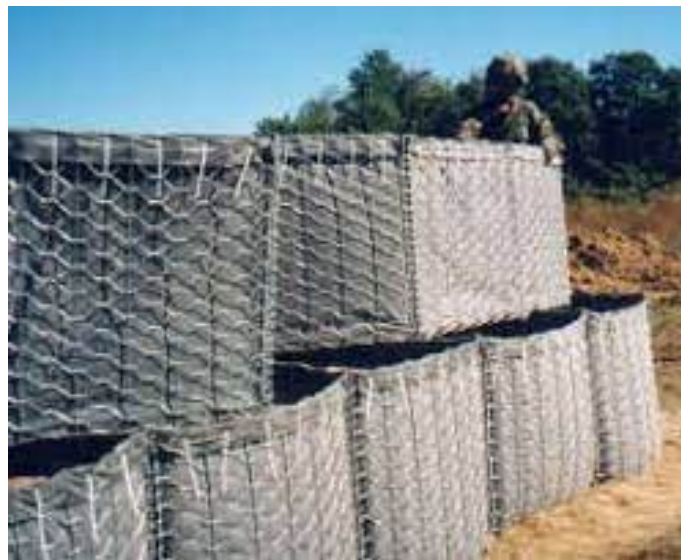
Obrázek 26: Gabionový díl - drátěný koš [32]
