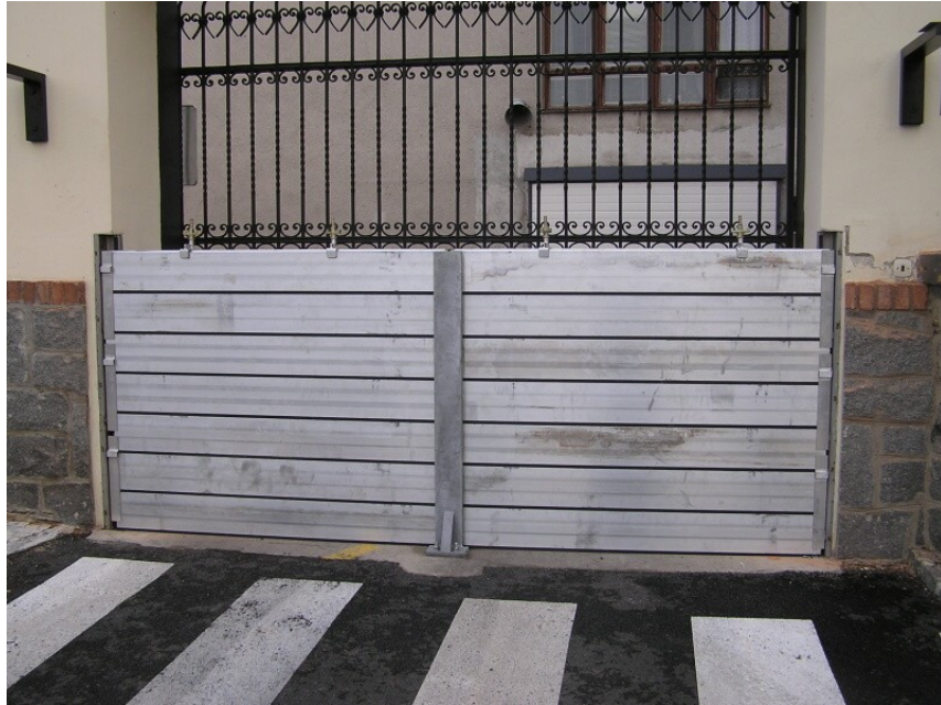
Obrázek 25: Hradidlový systém - ochrana dveří [44]
