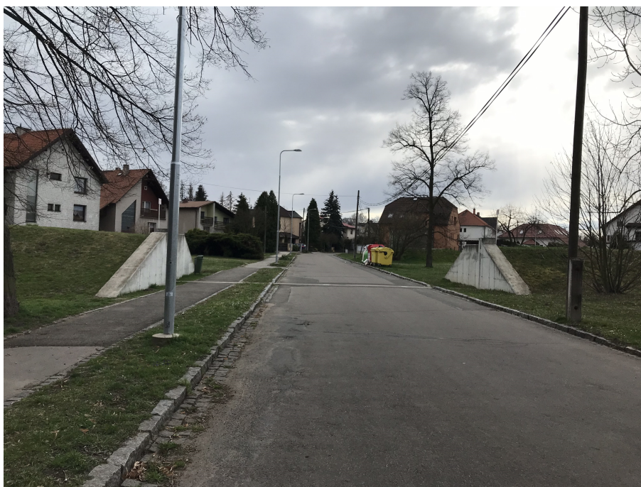
Obrázek 32: Polabec protipovodňový val okolo silnice
