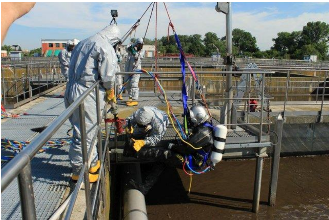
Obrázek 12 – Spouštění potápěče do odpadní jímky [60]
