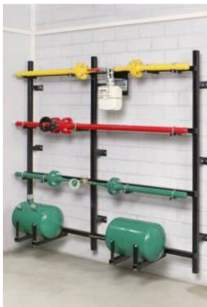
Obrázek 29 – Výcvikové zařízení s potrubními systémy [Zdroj autor]
