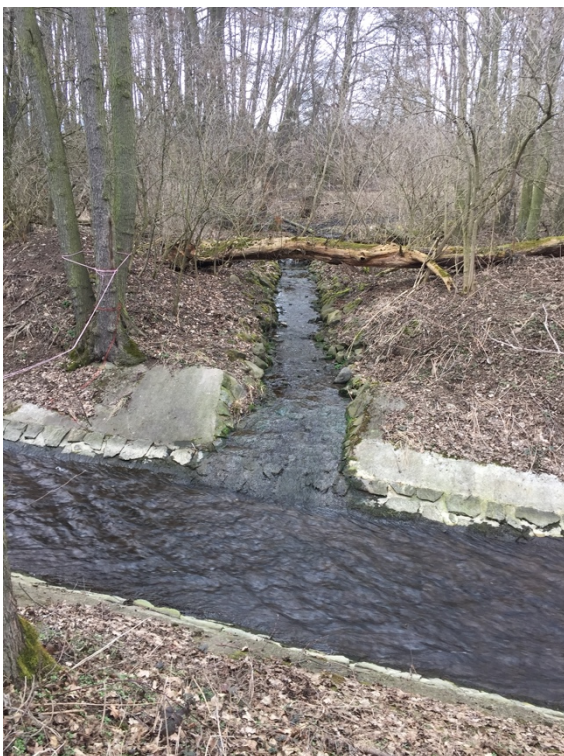
Pruněřovský potok v betonovém korytu
