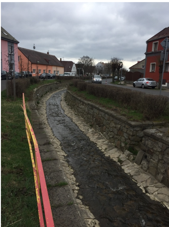
Potok Hačka ve Spořicích
