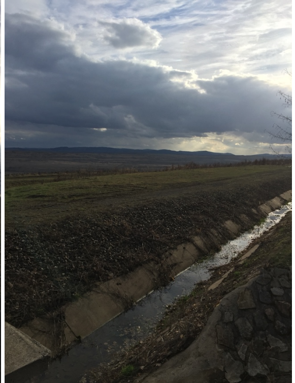
Betonové koryto u lomu
