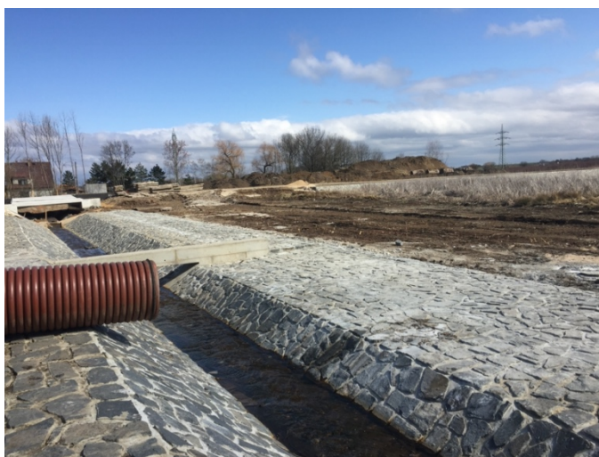
Vypuštěný Otvícký rybník a vydlážděné koryto
