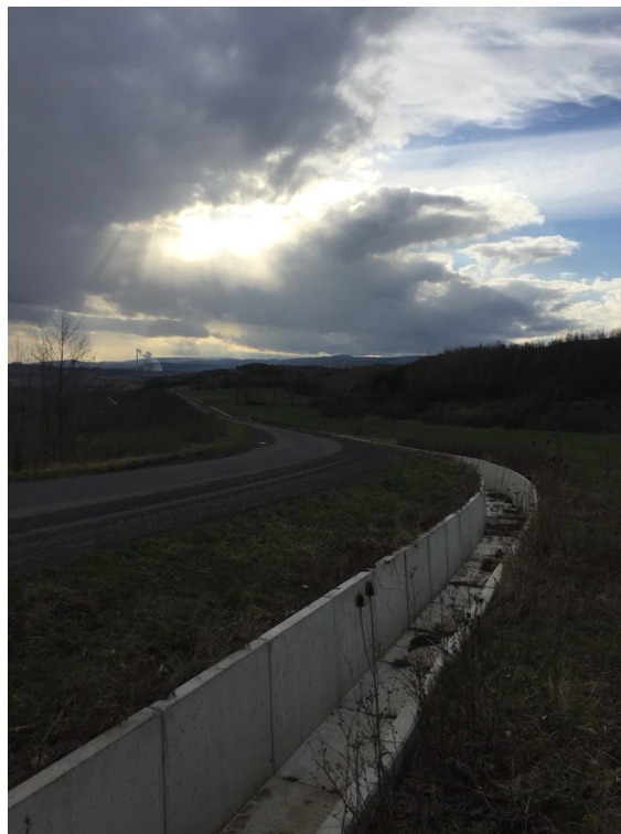
Betonové koryto u lomu
