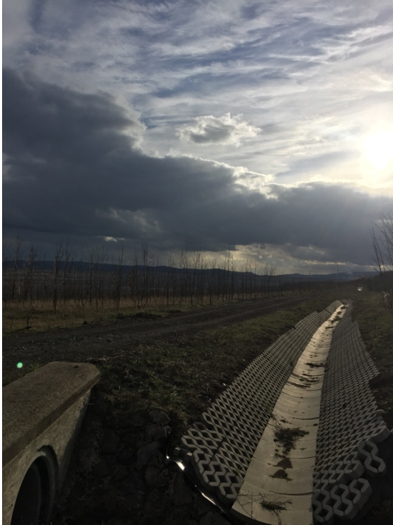
Vybudované betonové koryto u povrchového lomu Libouš
