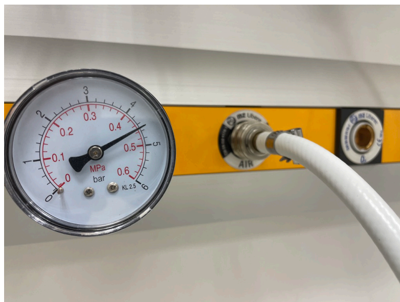
Obr. 4.6: Kontrola tlaku přívodního vzduchu.
