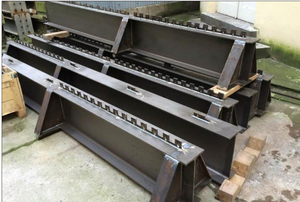
Obr. 129 Detail připravených nosníků s přivařenými lištami
