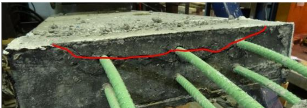
Obr. 55 Typické poškození horního povrchu v případě nedostatečné kotevní délky [107]
