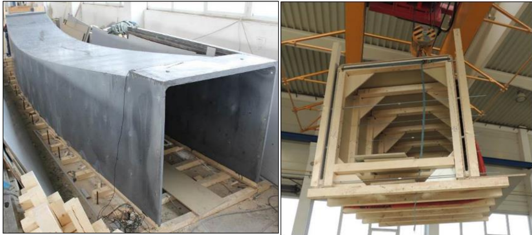
Obr. 13 Tenkostěnná lávka a její výroba. Vlevo prototyp lávky, vpravo část bednění [47]
