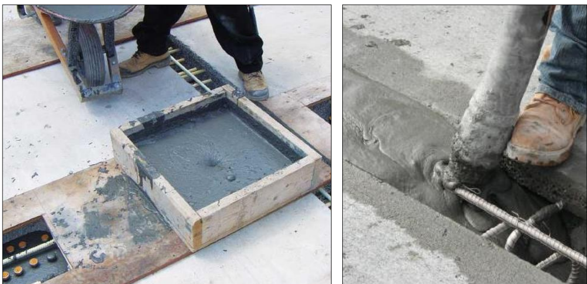
Obr. 64 Betonáž spojů s UHPC vlevo, čerpání UHPC pumpou vpravo [109,110]
