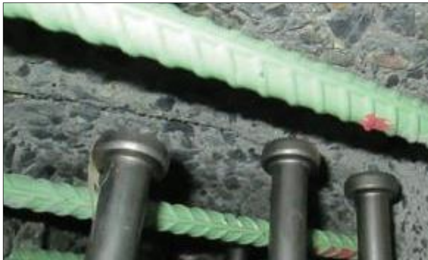
Obr. 62 Detail skrytého spřažení [104]
