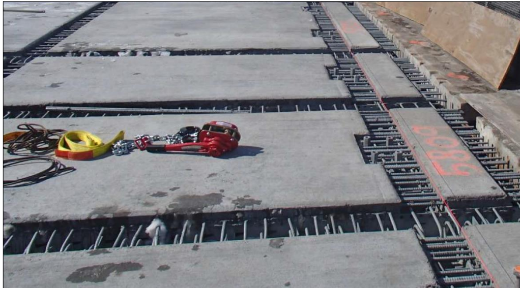
Obr. 67 Pulaski bridge – spoje připravené na dobetonování [111]
