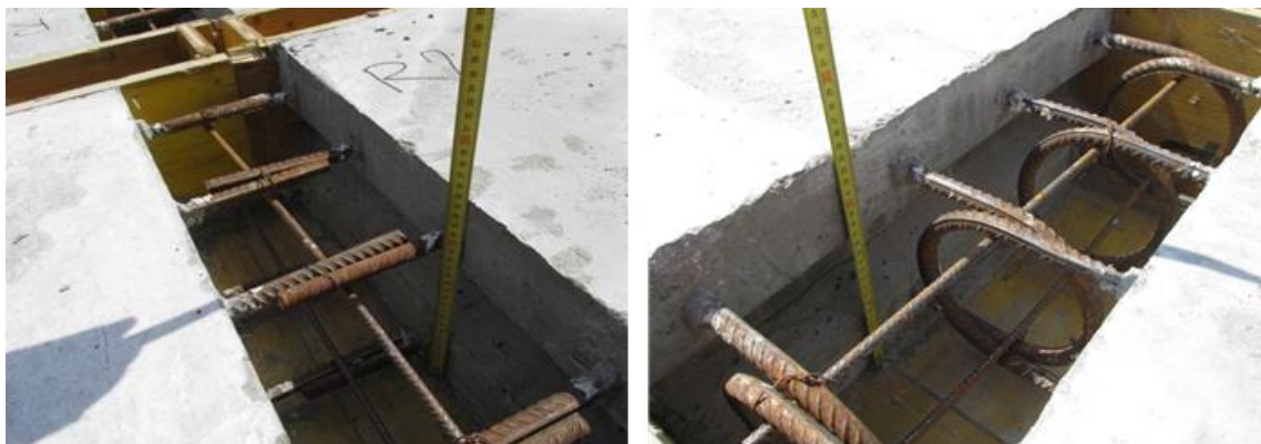
Obr. 103 Dvě varianty uspořádání výztuže ve spoji prefabrikátů
