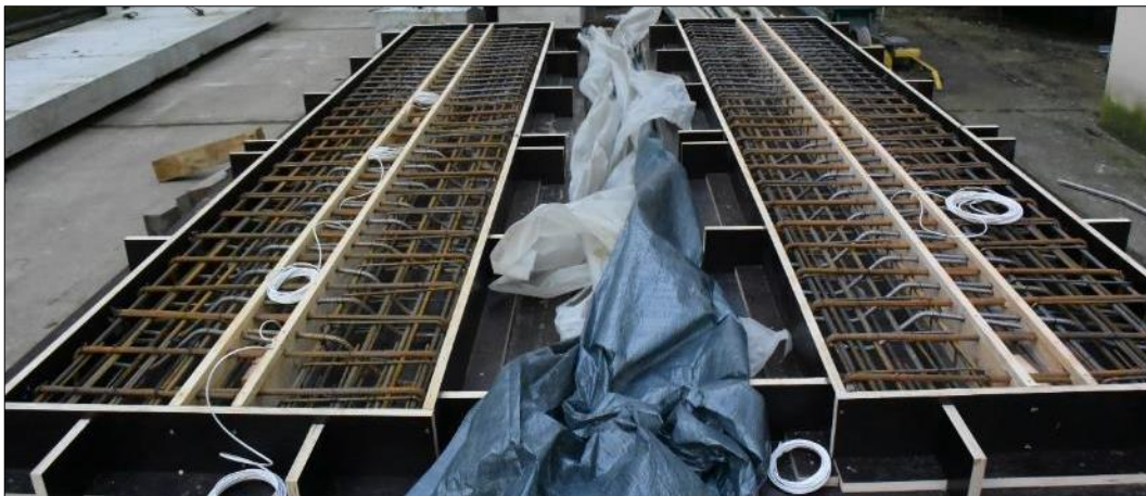
Obr. 135 Pohled na vyztužené vzorky před betonáží
