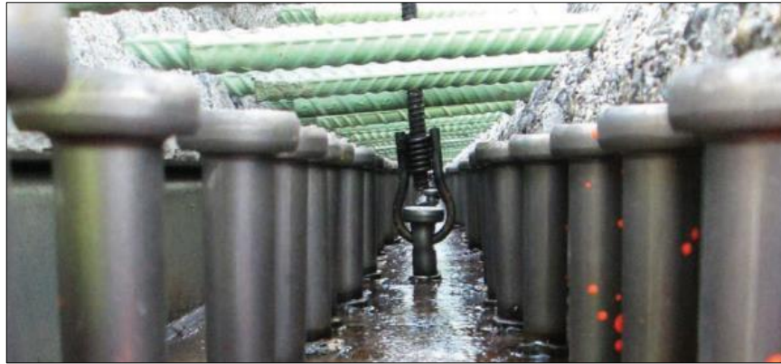
Obr. 59 Detail otevřeného spřažení [104]
