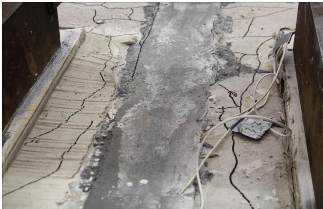
Obr. 142 Tvorba podélných trhliny mimo UHPC spoj
