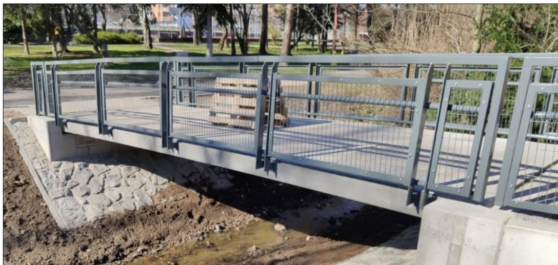
Obr. 9 Lávka malého rozpětí v Čelákovících [42]
