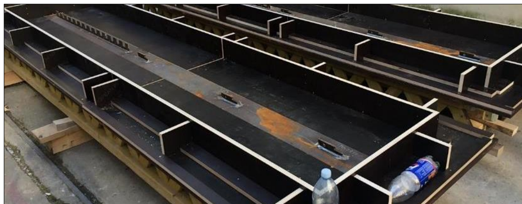
Obr. 134 Připravené bednění na variantu nosníku s UHPC spojem
