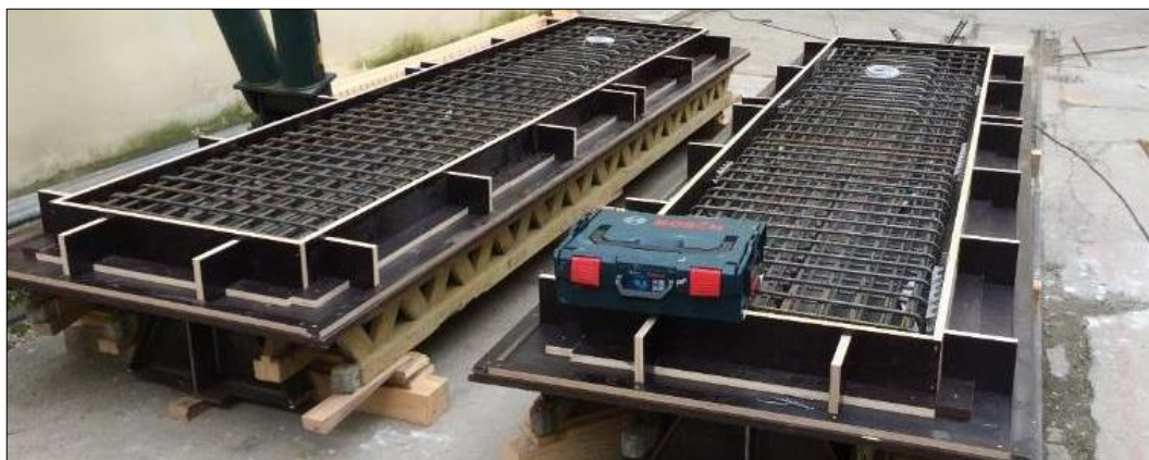
Obr. 136 Pohled na vyztužené vzorky před betonáží
