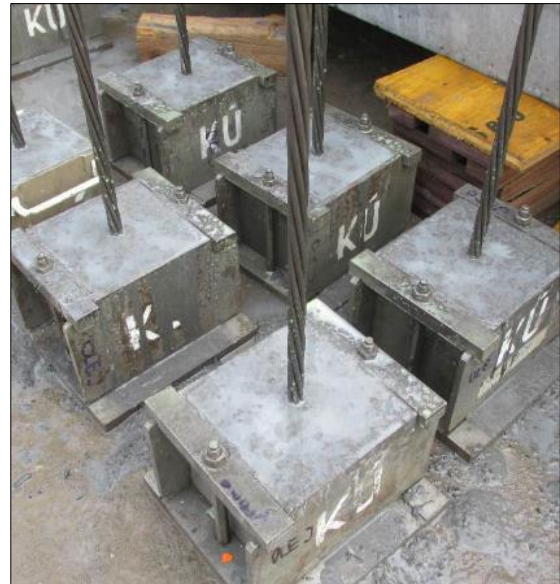
Obr. 44 Připravená forma s výztuží
