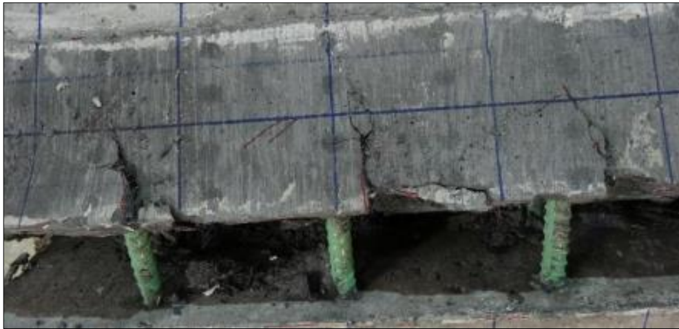
Obr. 54 Typické poškození horního povrchu v případě nedostatečné kotevní délky [107]
