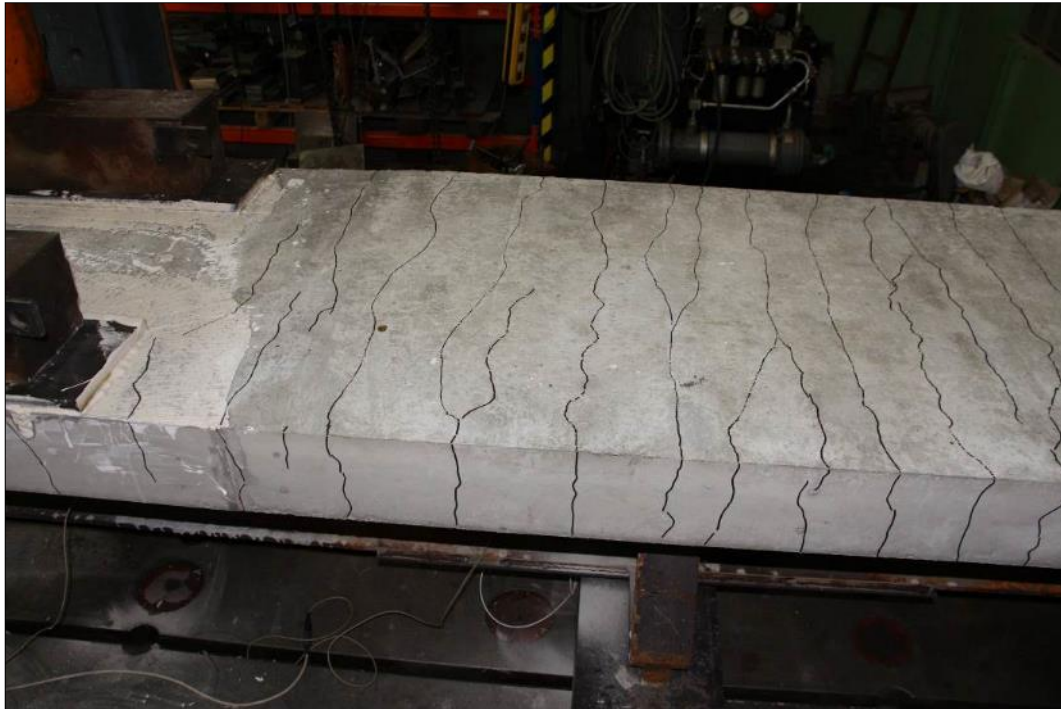
Obr. 145 Rozložení příčných trhlin před kolapsem nosníku s monolitickou deskou
