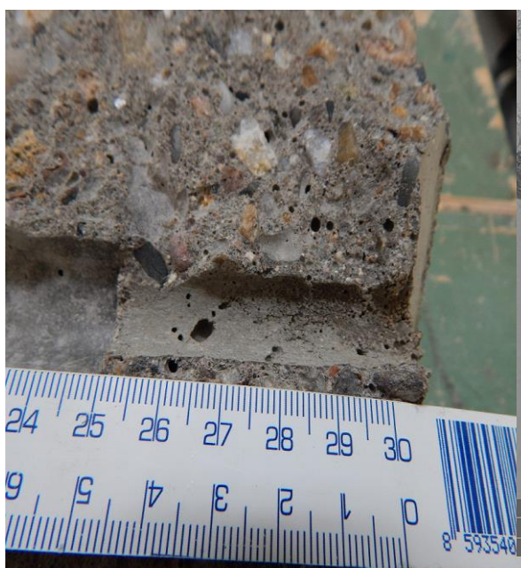
Obr. 97 Fázové rozhraní povlakovaného prutu a betonu po zkoušce soudržnosti
