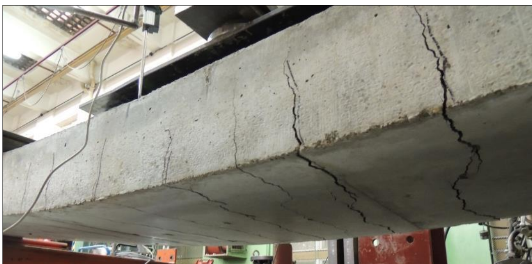
Obr. 107 Typické pravidelné rozložení trhlin vzorku zatíženého 4 bodovým ohybem
