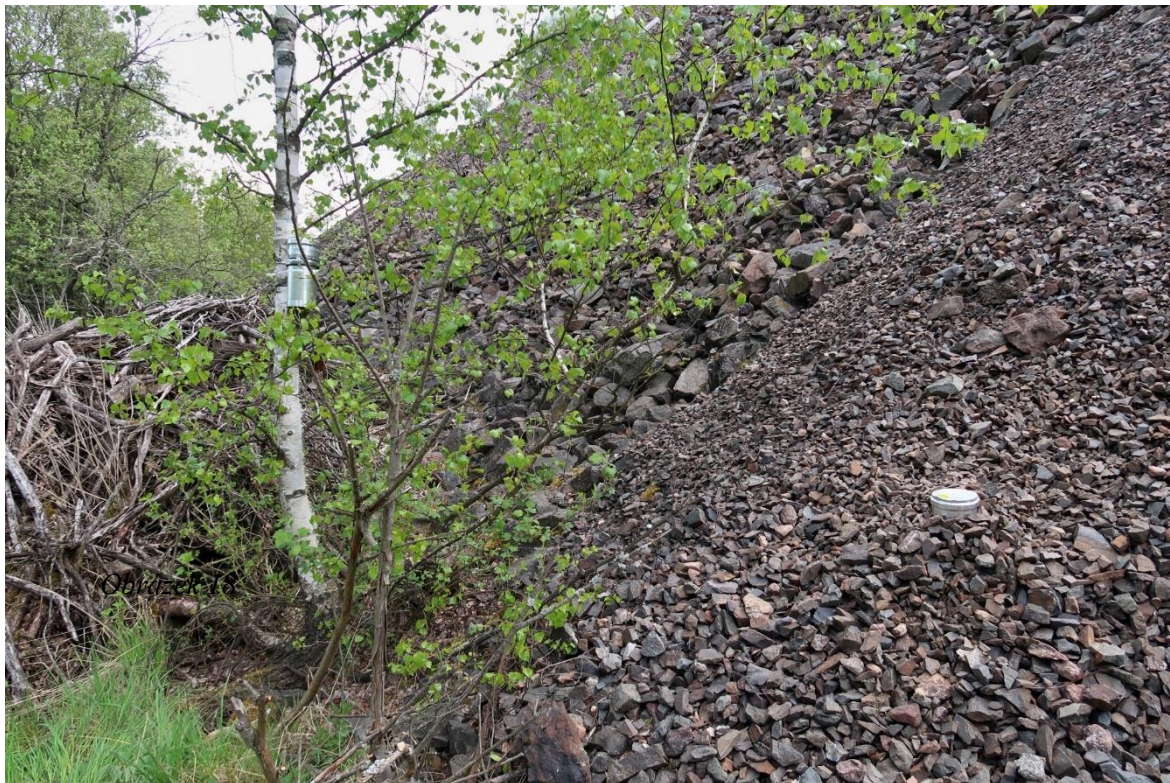
Obrázek 16 Ukázka rozmístění sond na patě odvalu, kdy jedna sonda je v hlušině a druhá sonda je připevněna na stromě (foto: Jan Hradecký)
