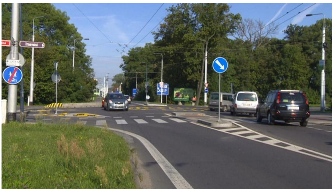
Obr.6 – Tichý asfalt v Pardubicích (Zdroj: [17])
