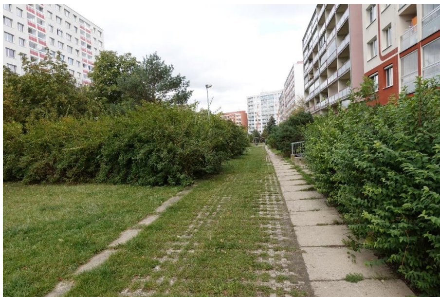
Obrázek 8 - Provedení nástupní plochy pomocí zatravnovací dlažby [24].
