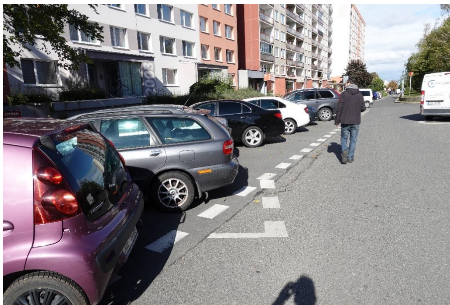
Obrázek 22 – Příklad nedokonalého odstranění starého VDZ [24].
