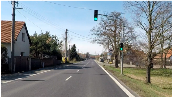
SSZ s dynamickým řízením, Vavříneč.
