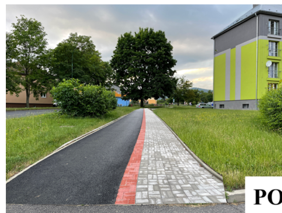
Obrázek 10 – Část trasy 12 po úpravě, zdroj fotografie: autor, upraveno autorem
