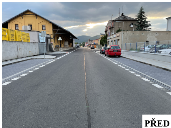
Obrázek 7 – Nádražní ulice před úpravou, zdroj fotografie: autor
