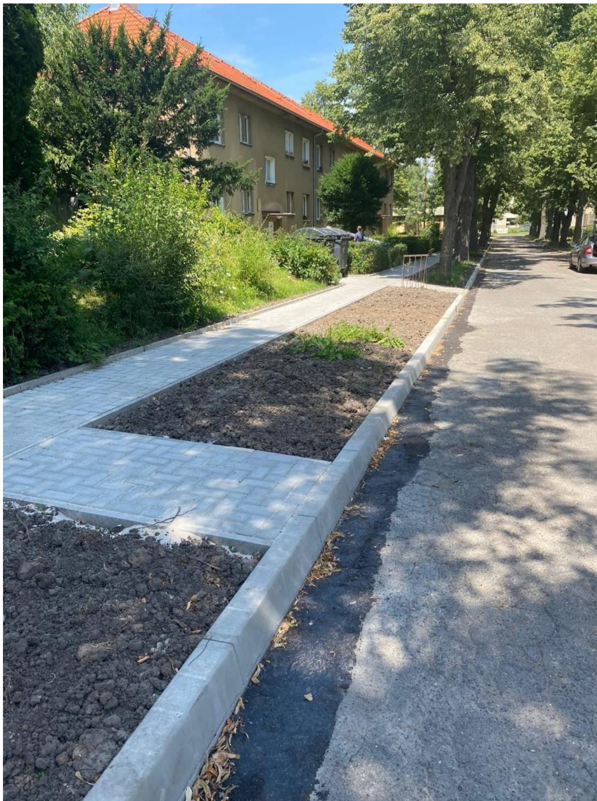
Obrázek 17: Ukázka nového chodníku v ulici č. 3
