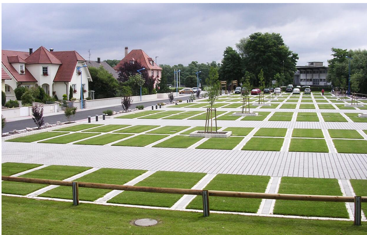
Obrázek 24: Ukázka parkovací plochy s využitím zatravnovací dlažby
