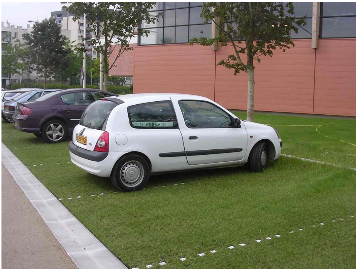
Obrázek 23: Ukázka parkovací plochy s využitím zatravnovací dlažby
