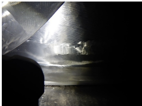
Obr. č. 22 Kavitační poškození OL elektrárny ESL
