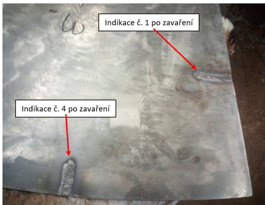
Obr. č. 72 OL č.3 po zavaření trhlin
