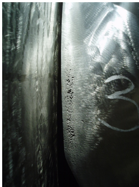
Obr. č. 18 .Kavitační poškození OL elektrárny EOR
