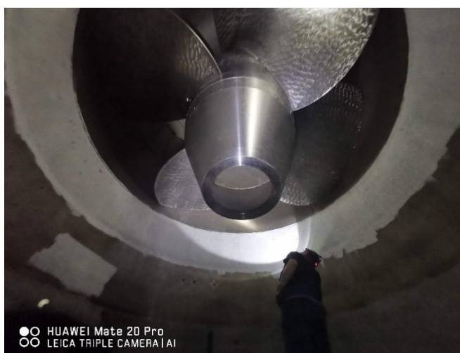
Obr. č. 20 OK elektrárny EKA
