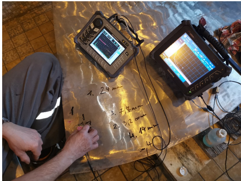
Obr. č. 70 Kontrola OL 3 pomocí metody UT
