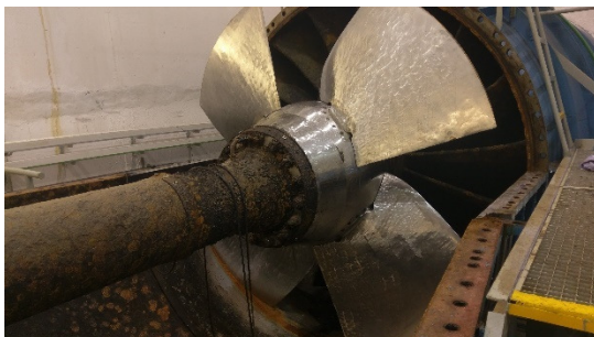
Obr. č. 17 OK elektrárna EKO
