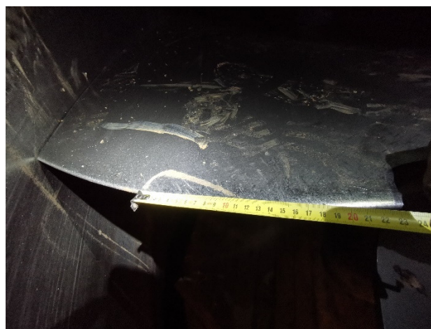
Obr. č. 28 Mechanické poškození OL elektrárny EVR
