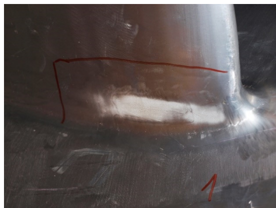
Obr. č. 33 Kavitační poškození OL elektrárny EDS
