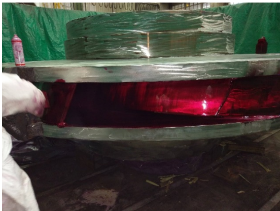
Obr. č. 34 NDT na OK elektrárny EDS
