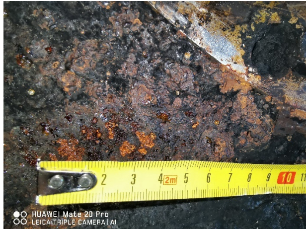
Obr. č. 14 Kavitační poškození u čepu OL
