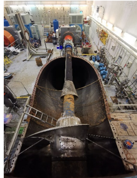
Obr. č. 47 Demontáž turbíny TG1
