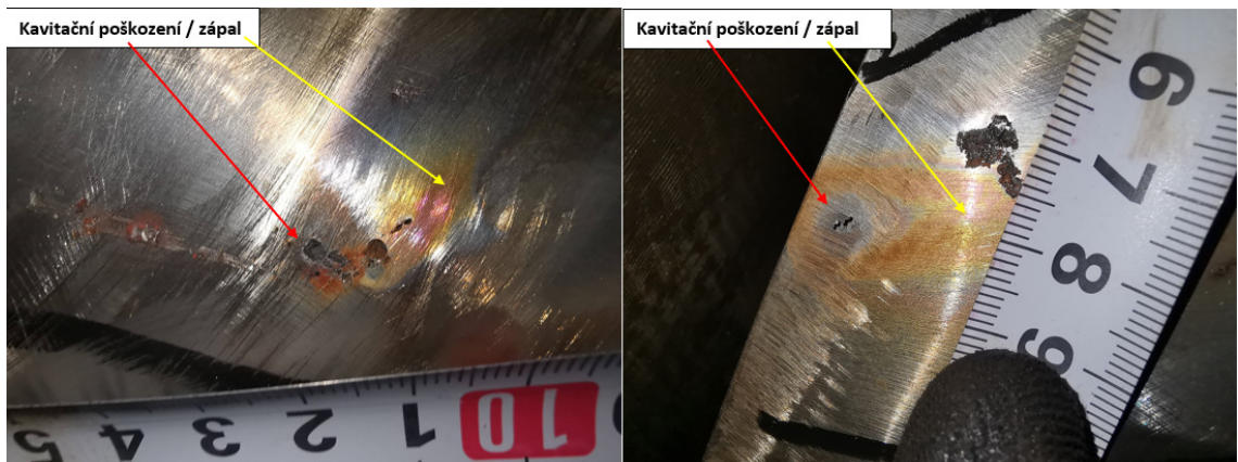
Obr. č. 53 Kavitační poškození na OL č. 2
