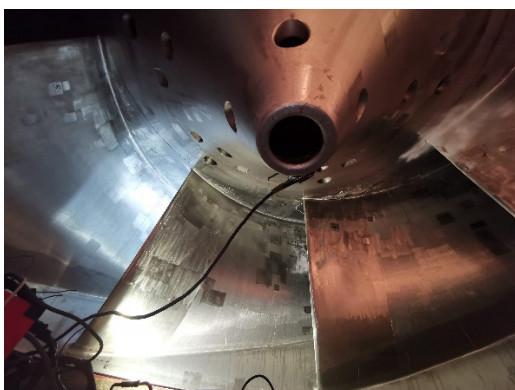
Obr. č. 31 OK elektrárny EDA
