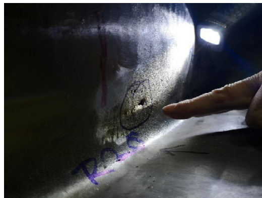
Obr. č. 30 Kavitační poškození OL elektrárny EDA
