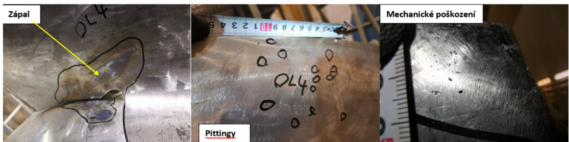
Obr. č. 56 OL č. 4. Zápal/pittingy/ mechanické poškození
