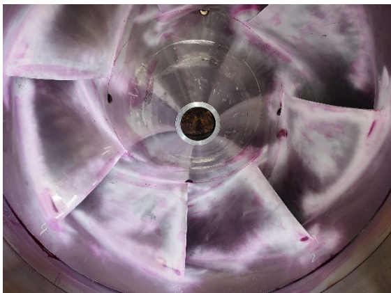
Obr. č. 27 NDT na OK elektrárny EST III
