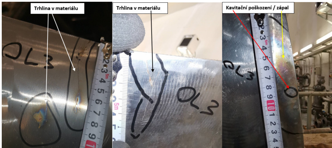
Obr. č. 54 OL č. 3. Trhliny v materiálu / kavítace
