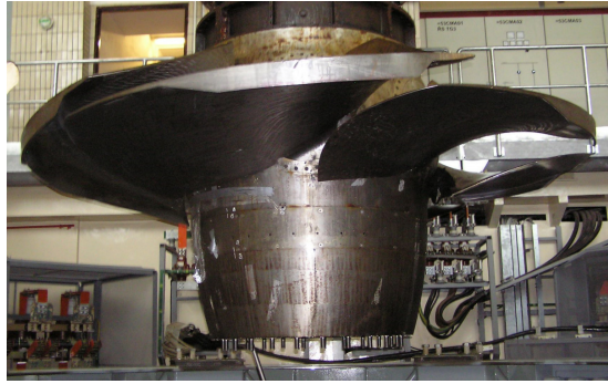
Obr. č. 38 Úprava OL proti kavitačnímu poškození, OK ESL
