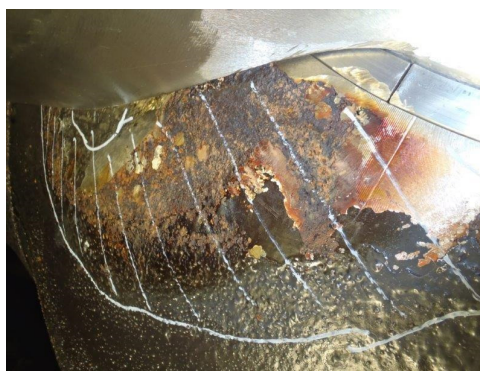
Obr. č. 24 Kavitační poškození náboje OK EST
