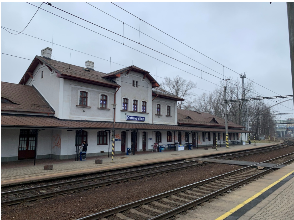
Fotografie 8.: Výpravní budova pohled z ostrovního nástupiště
