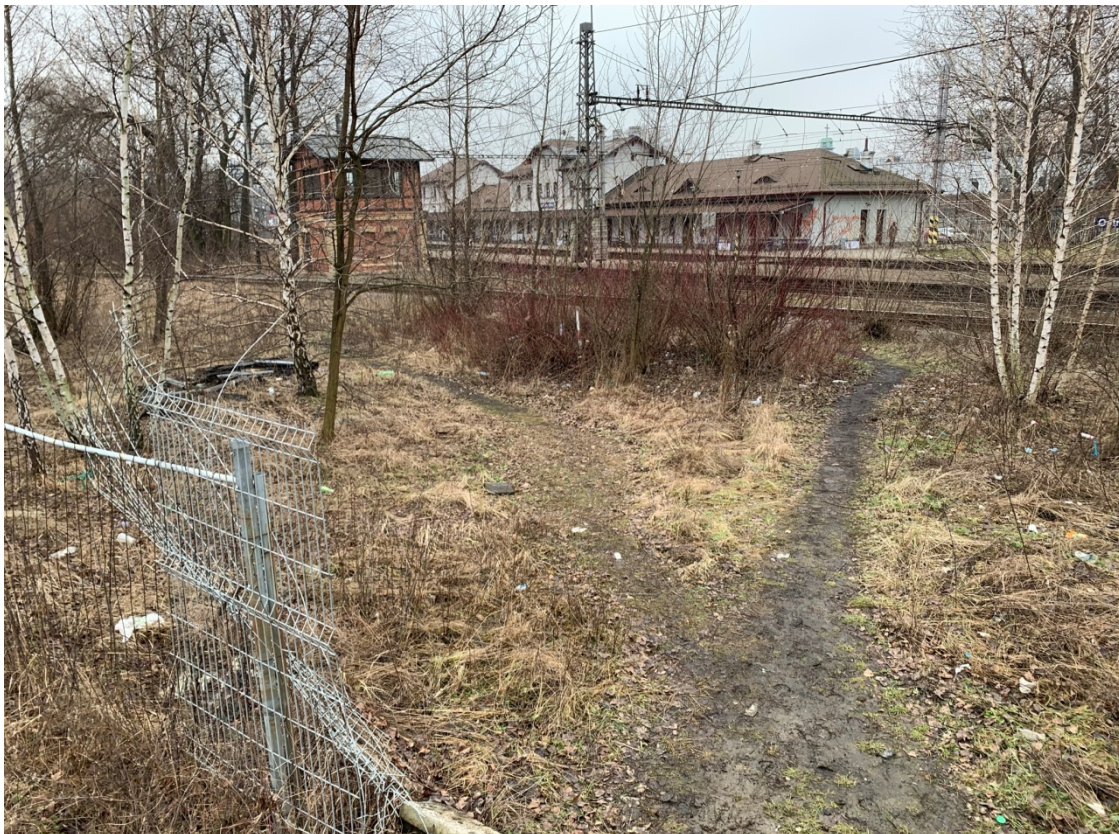
Fotografie 19.: Zničené oplocení ohraničující drážní pozemek u trolejbusové zastávky U lávky Nová Karolína
