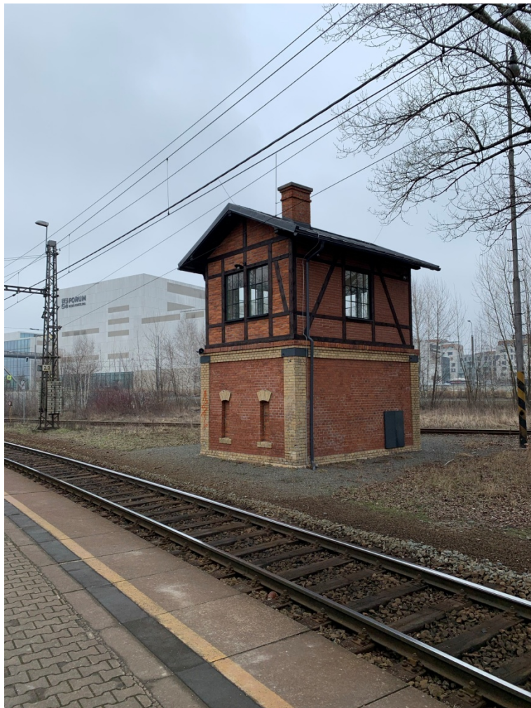
Fotografie 11.: Historická budova stavědla
