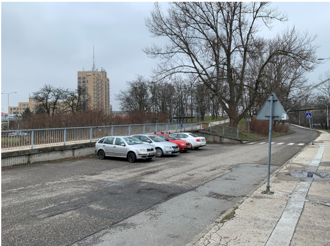
Fotografie 3.: Parkovací stáji před výpravní budovou
