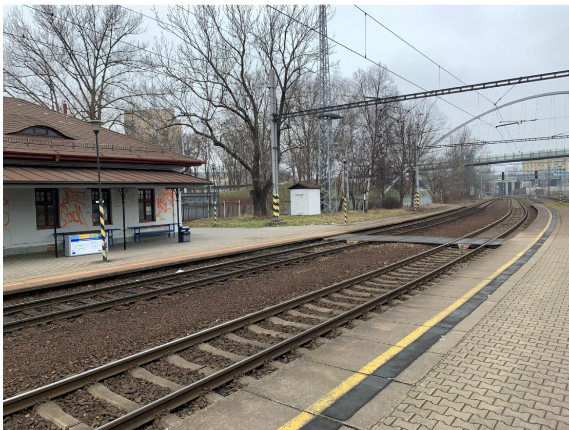
Fotografie 10.: Úroňový přístup na ostrovní nástupiště u zhlaví ve směru Ostrava hl.n.
