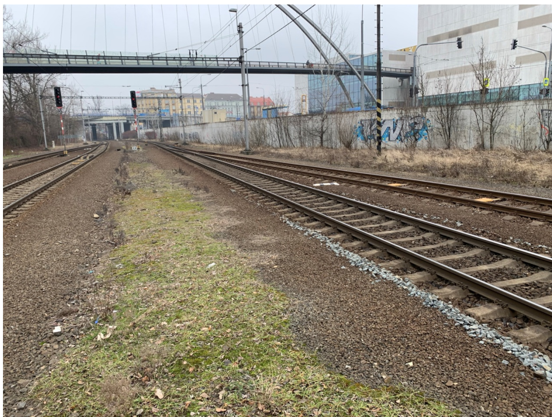
Fotografie 16.: Pohled do zhlaví ve směru Ostrava hl.n.
