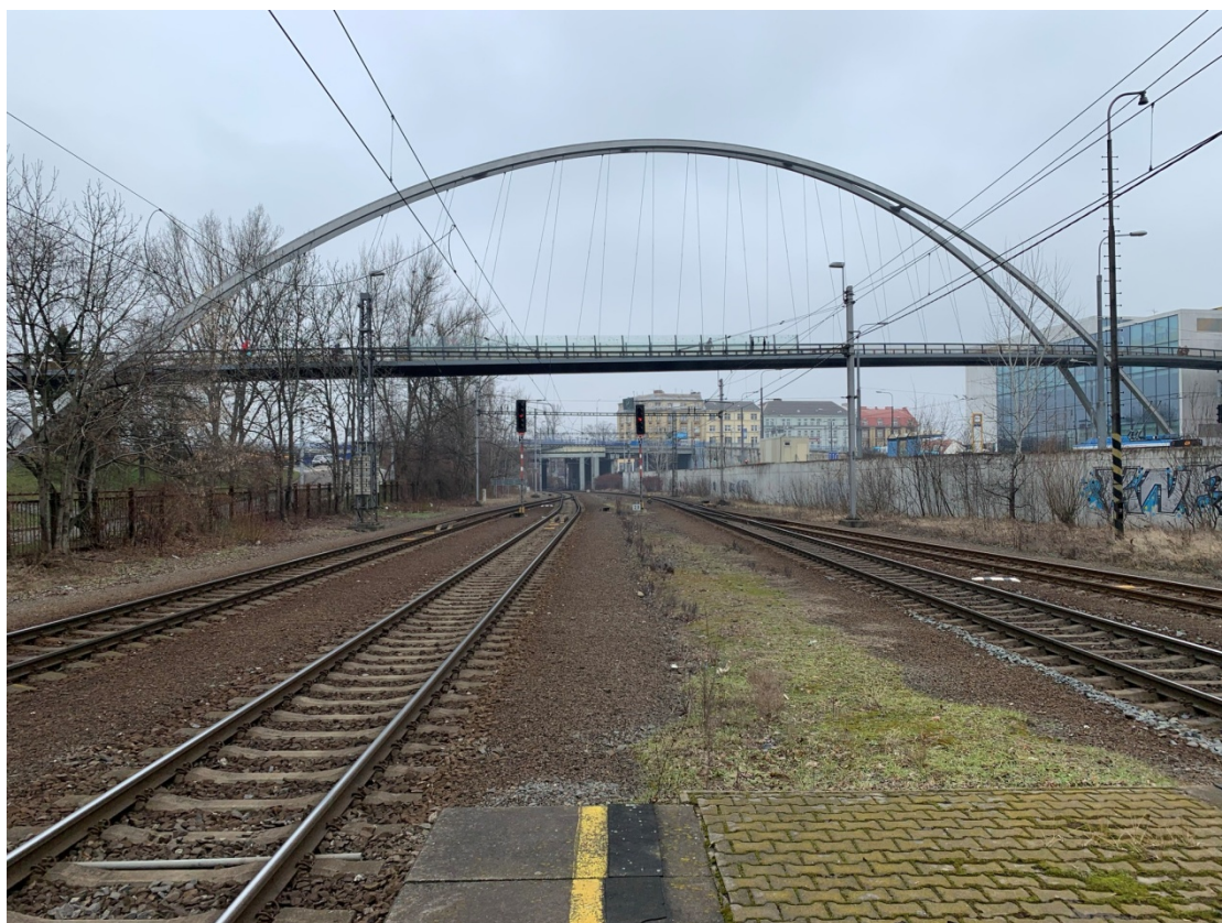
Fotografie 14.: Pohled do zhlaví Ostrava hl.n.
