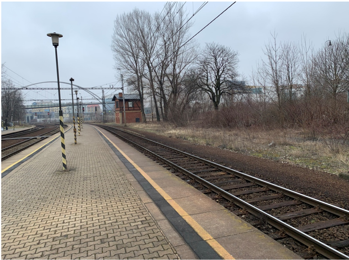
Fotografie 7.: Ostrovní nástupiště v pozadí historická budova staveřla
