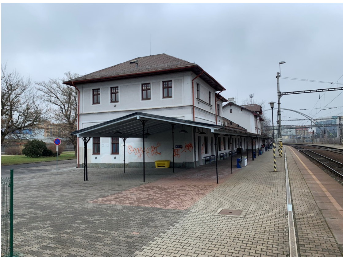
Fotografie 3.: Pohled na výpravní budovu z krajního nástupiště
