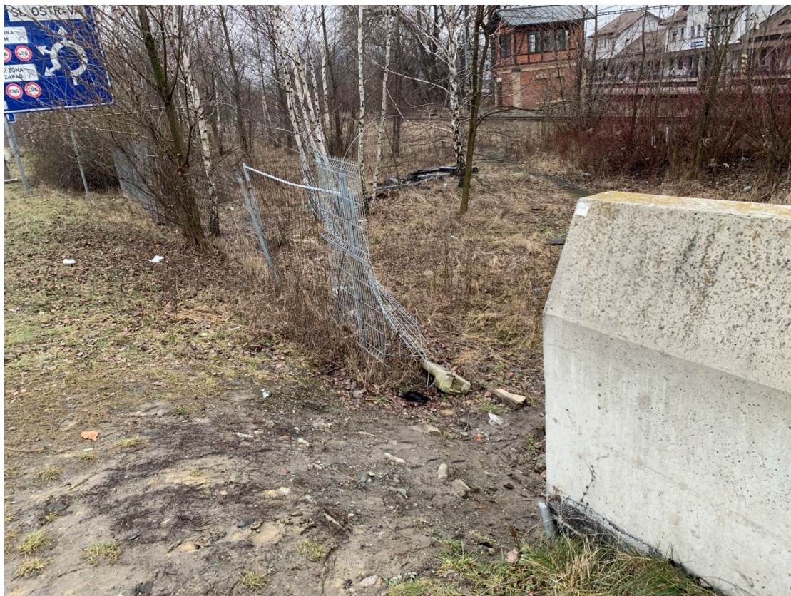
Fotografie 18.: Zničené oplocení ohraničující drážní pozemek u trolejbusové zastávky U lávky Nová Karolina
