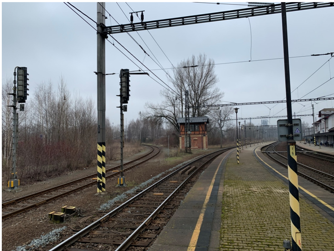
Fotografie 15.: Pohled na vlečku č. 6070 (nalevo), historické stavědlo a ostrovní nástupiště
