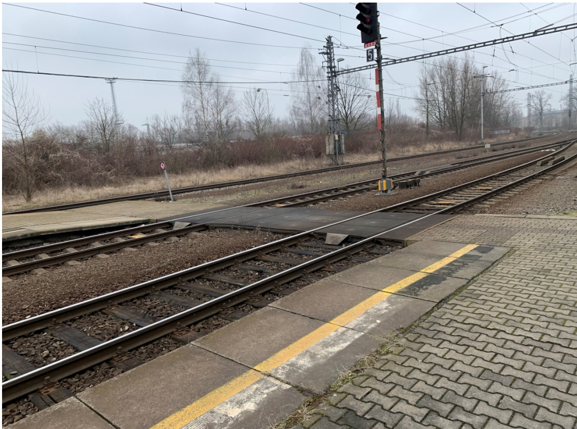
Fotografie 4.: Úrovňový přístup na ostrovní nástupiště u zhlaví ve směru Ostrava-Kunčice
