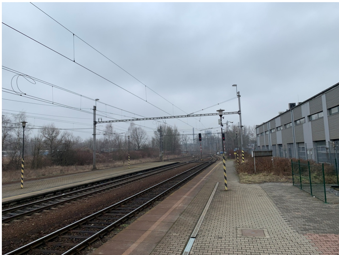
Fotografie 5.: Pohled do zhlaví ve měru Ostrava-Kunčice
