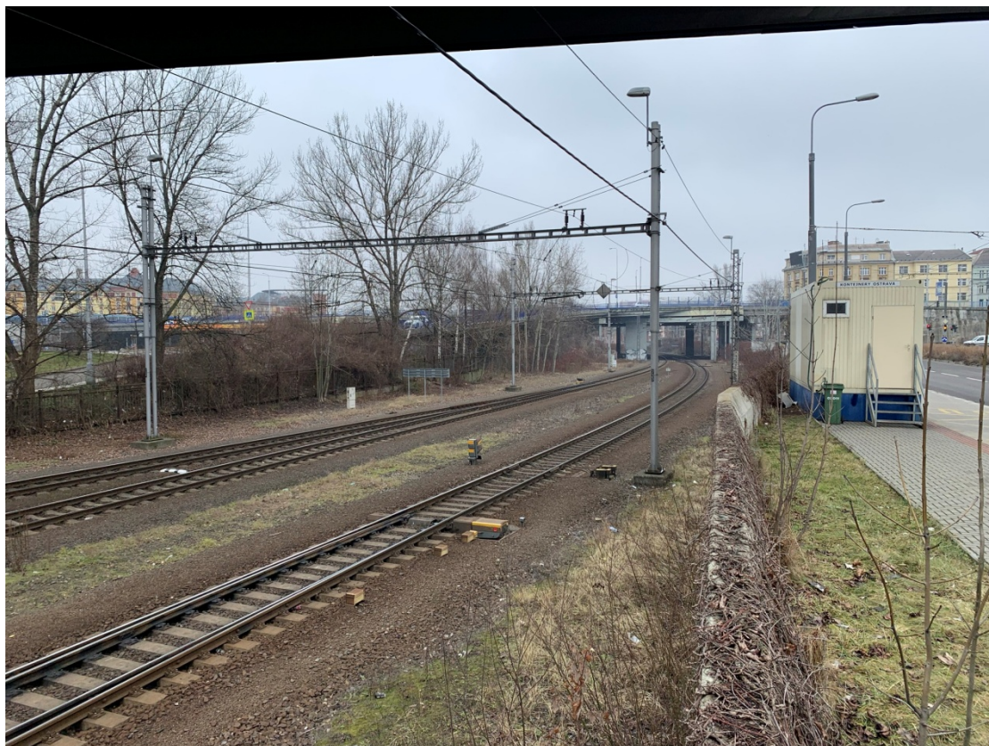
Fotografie 17.: Pohled do zhlaví ve směru Ostrava hl.n.
