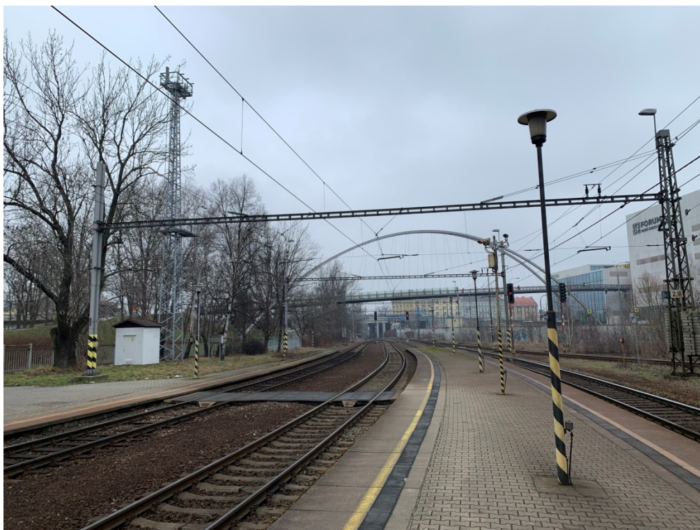
Fotografie 12.: Pohled do zhlaví stanice ve směru Ostrava hl.n.
