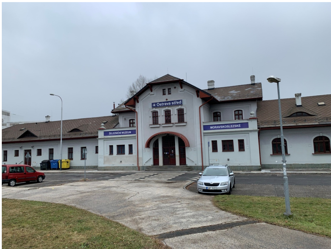
Fotografie 1.: Výpravní budova pohled z přednádraží
