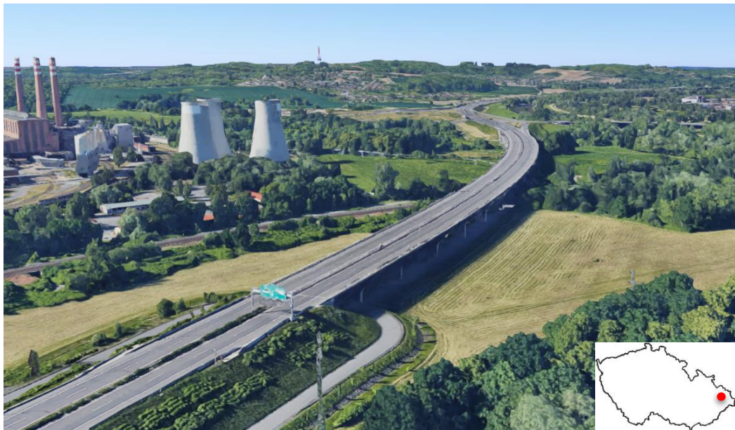
Obrázek 34: Dálniční most (SO 216) Ostrava-Svinov [55]
