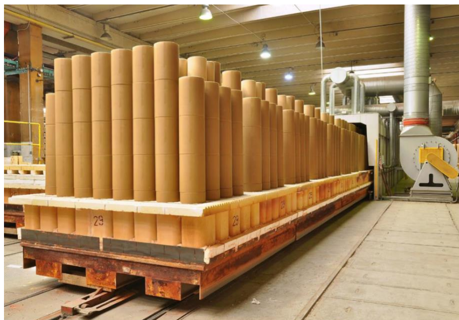
Obrázek 28: Sloupce KKV umístěné na pecních vozech [15]
