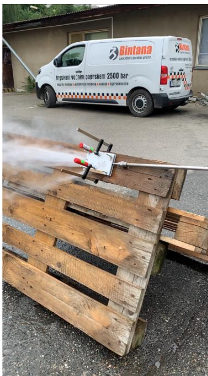
Obrázek 26: Tryskání přípravku
