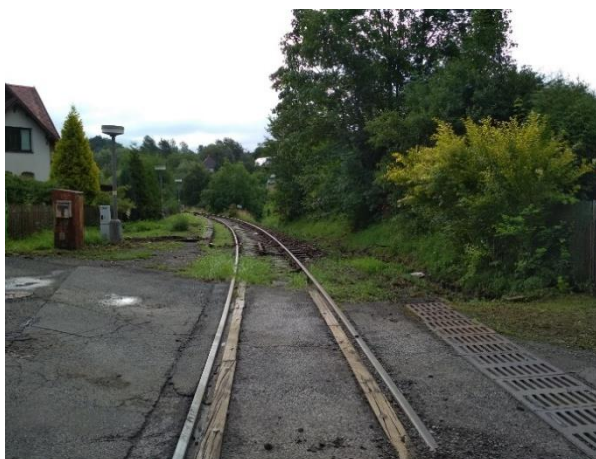
Obrázek 24 – Aktuální stav železničního přejezdu P2007 (Děčín - Oldřichov), autor
