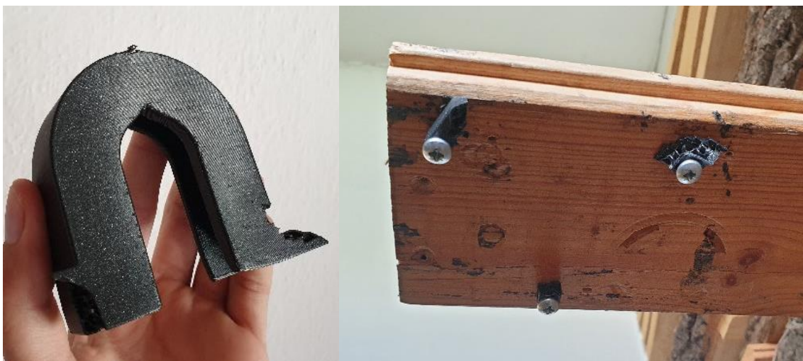
Obr. 57: Prasklý držák a zbytky držáku přišroubované k prknu
