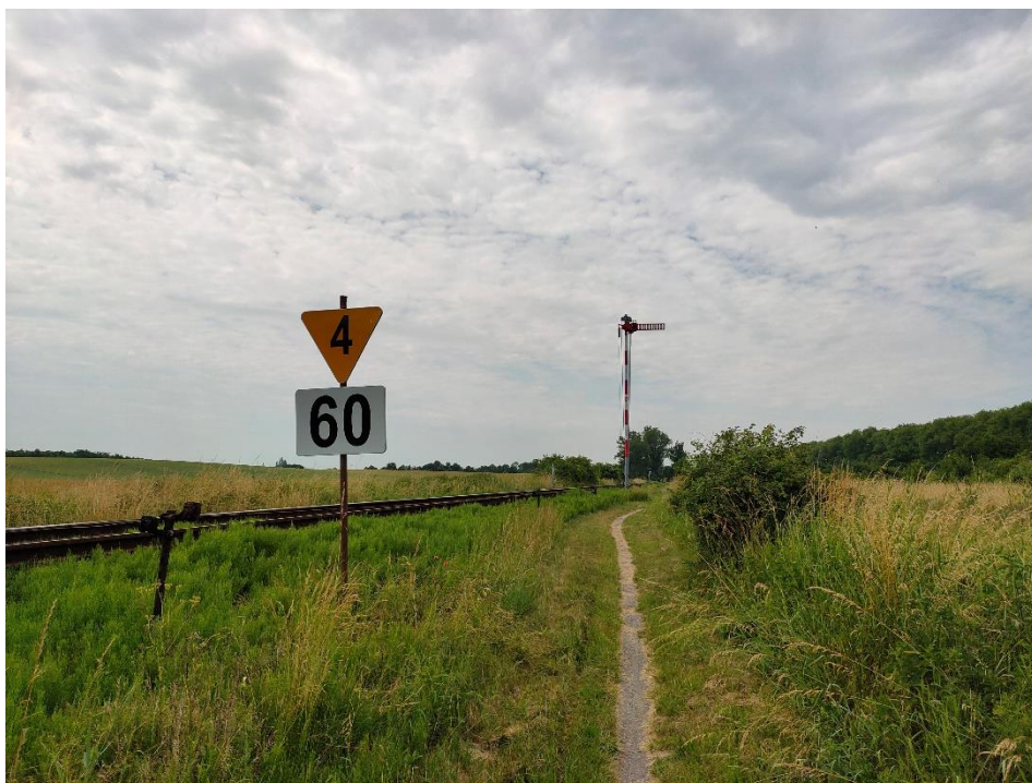
Obrázek 59: Vjezdové návěstidlo stanice Křinec 9
