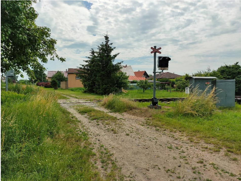
Obrázek 51: Železniční přejezd P4593 4
