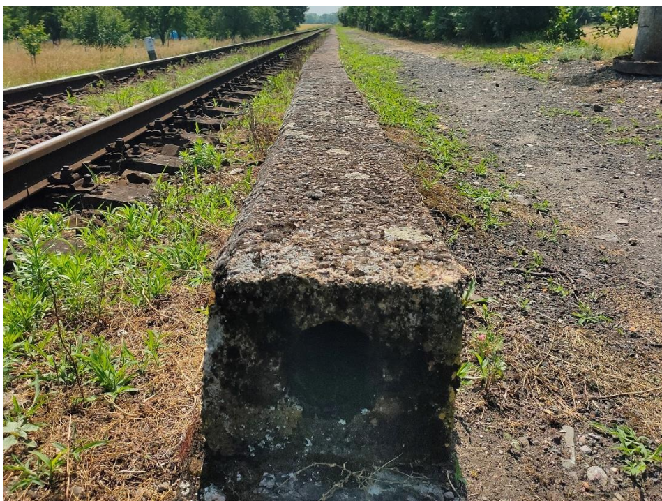
Obrázek 63: Detail nástupní hrany typu Tischer v Ledečkách 12
