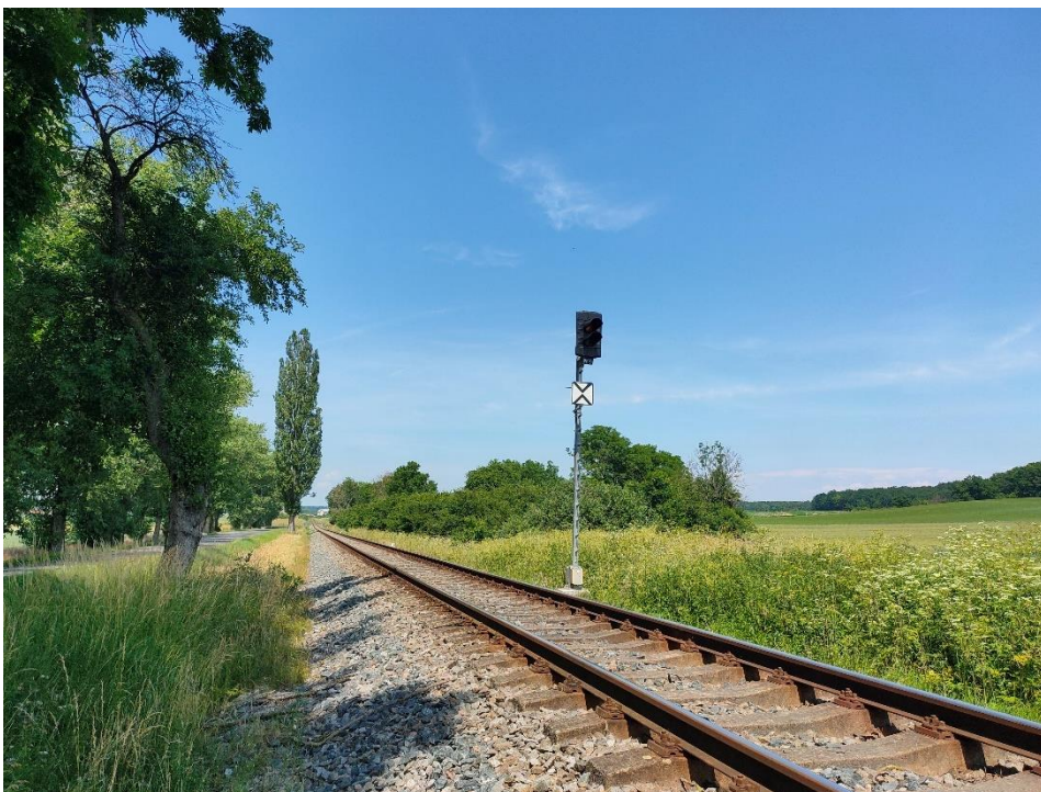
Obrázek 64: Světelná předvěst vjezdového návěstidla stanice Rožďalovice
