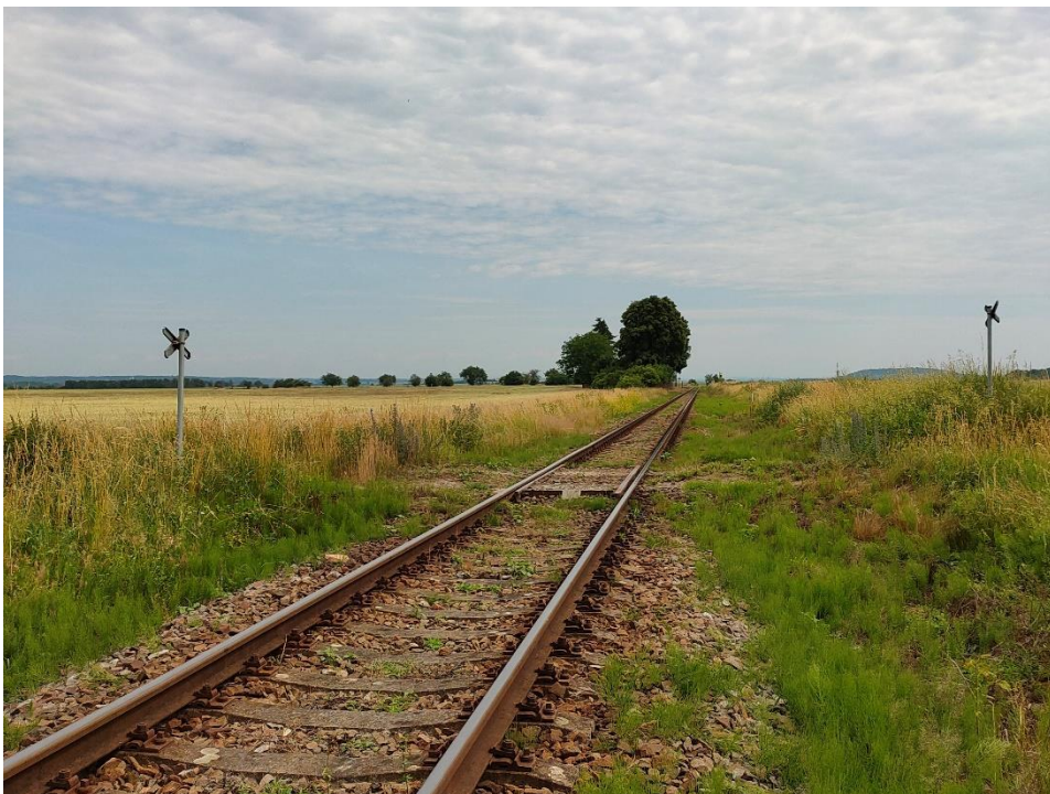
Obrázek 52: Železniční přejezd P4597 5
