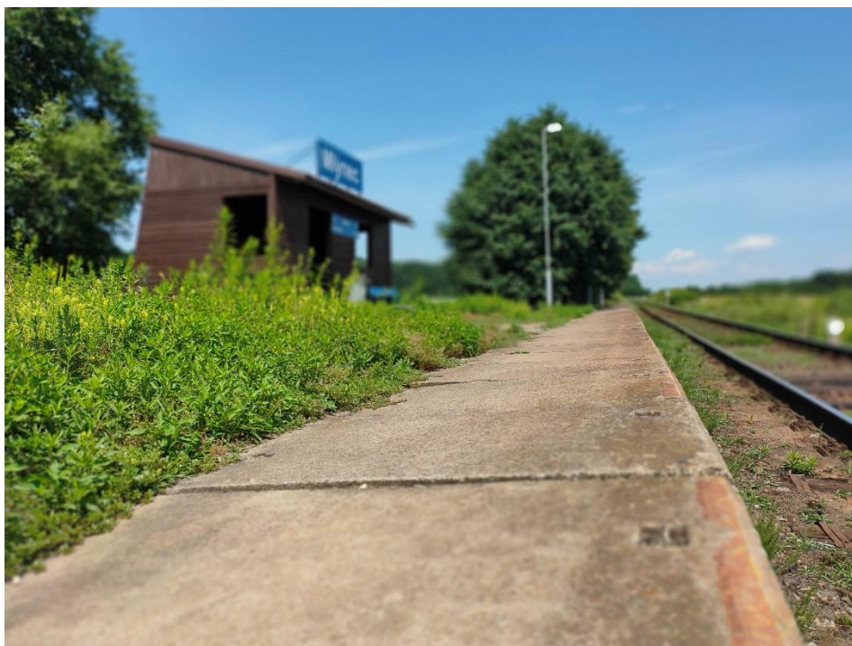
Obrázek 67: Detail nástupní hrany typu SUDOP v Mlýnci 14
