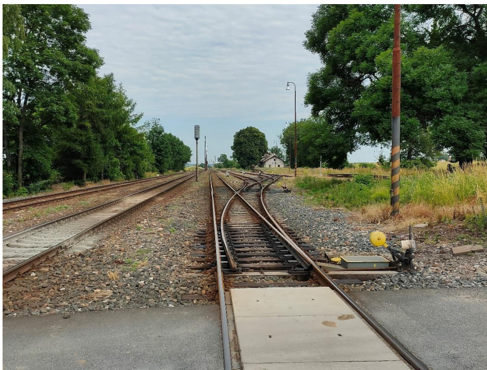
Obrázek 49: Stanice Veleliby, pohled od přejezdu P2787
