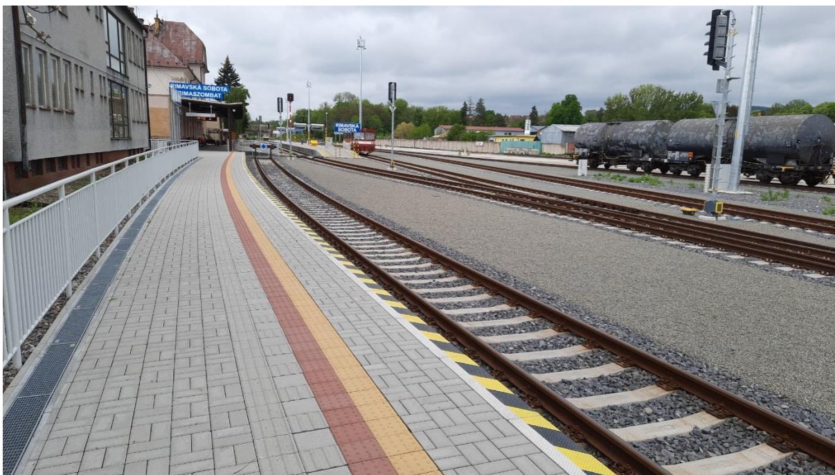
14.5.2021, Žst. Rimavská Sobota [Slovensko], nást. 1., aktuální vyhotovení ochranných pásů na nástupištích na síti ŽSR, pohled na kolejiště od Jesenského zhlaví
