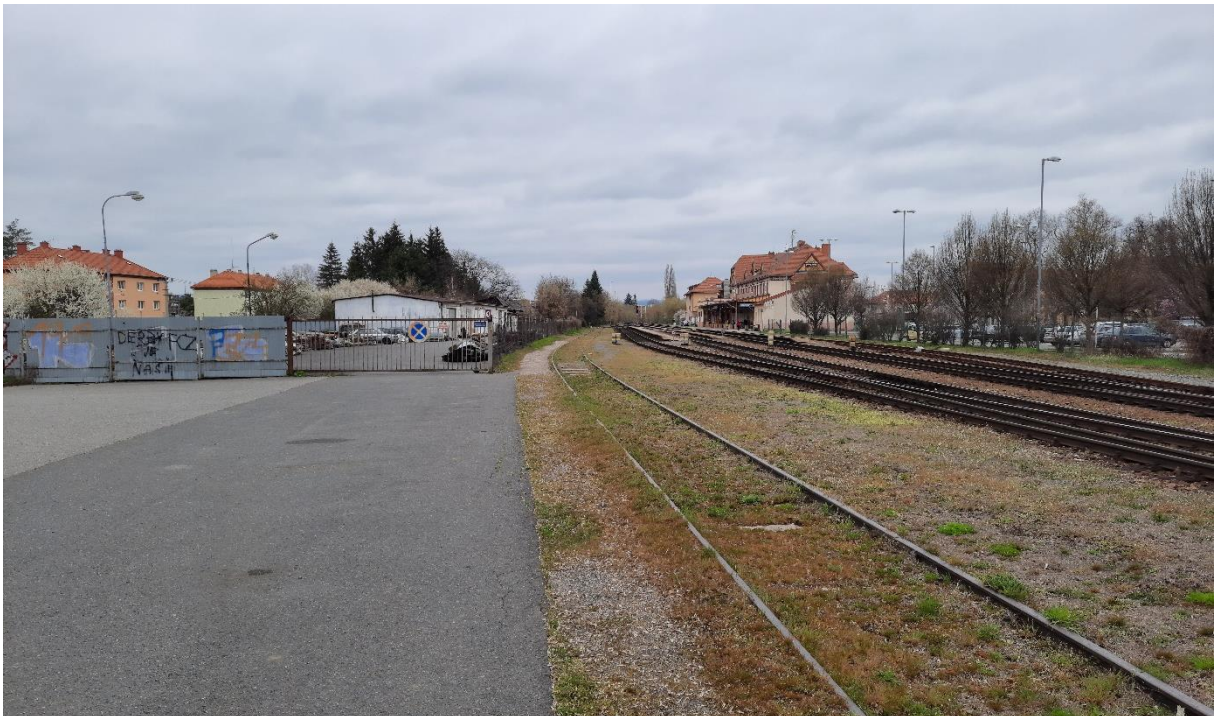
16.4.2021, Žst. Uherské Hradiště, pohled od volné skládky
