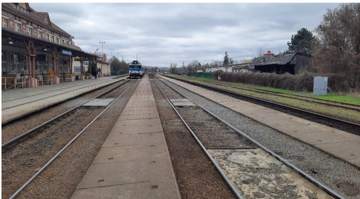
Obr. 31 - Kolejiště žst. Uherské Hradiště, pohled z 2. nástupiště ke Kunovickému zhlaví
