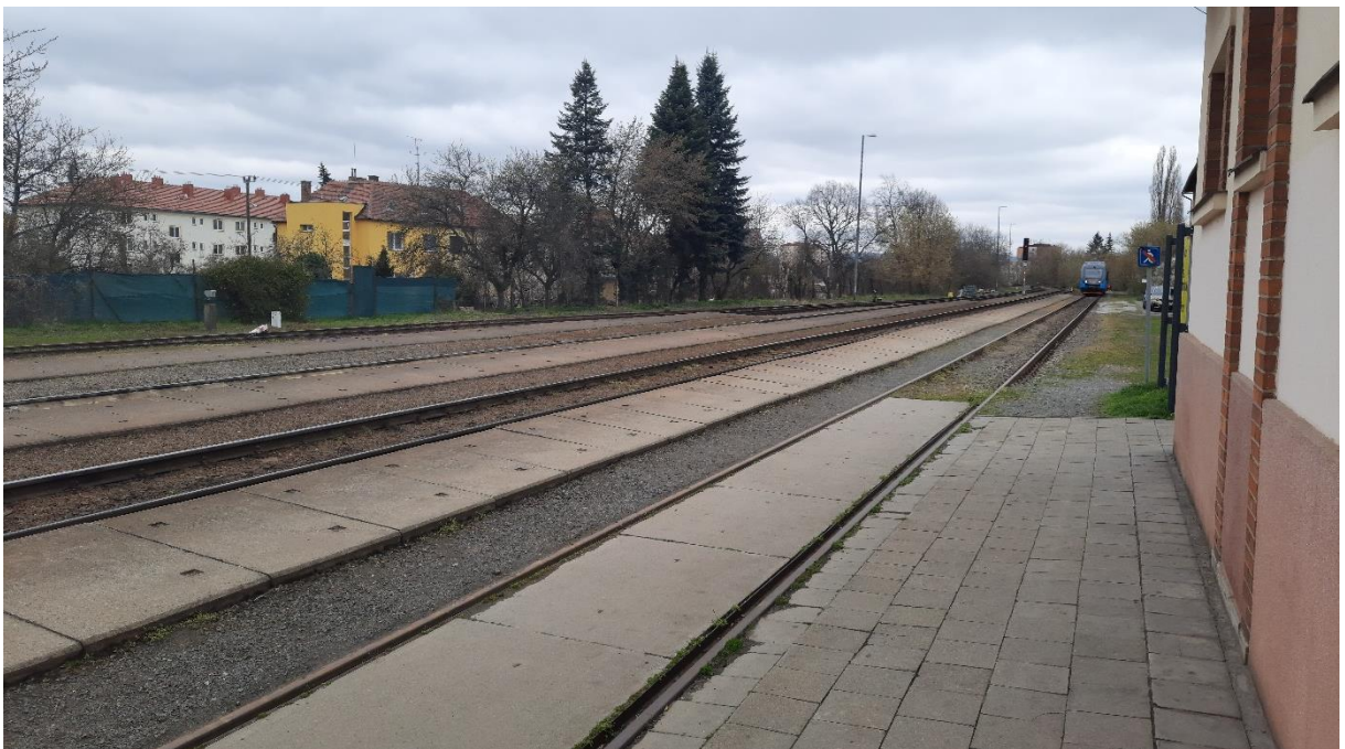
16.4.2021, Žst. Uherské Hradiště, pohled od výpravní budovy směr Staré Město
