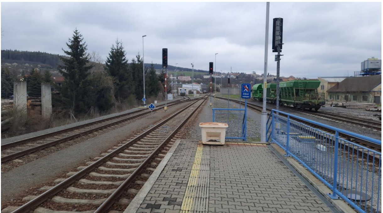
16.4.2021, Žst. Bojkovice, pohled na Bylnické zhlaví z nástupiště 2., vpravo volná skládka a vlečka
