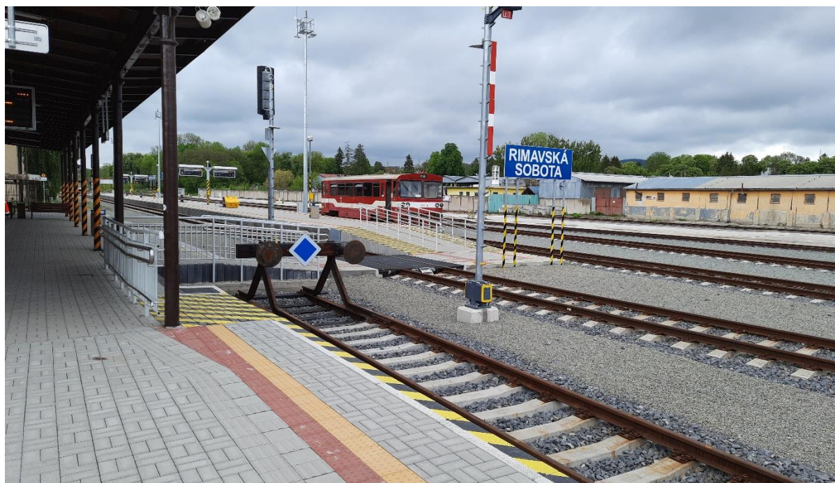
14.5.2021, Žst. Rimavská Sobota [Slovensko], detail řešení úroňového přístupu na nást. 2.
