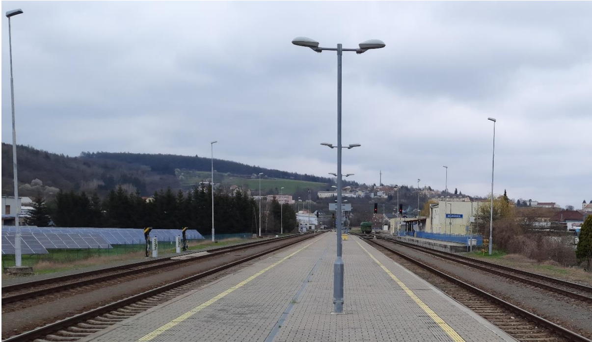
Obr. 43 - Kolejiště žst. Bojkovice, pohled z 2. nástupiště od Uherskobrodského zhlaví
