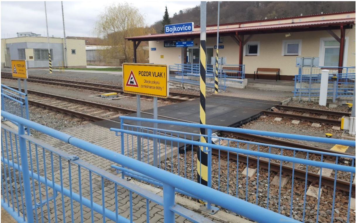
16.4.2021, Žst. Bojkovice, detail centrálního úrovňového přechodu
