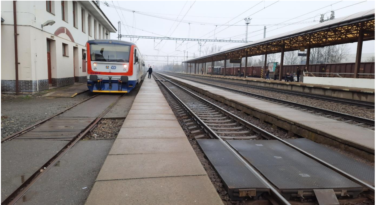
Obr. 20 - Kolejistiště žst. Svitavy, pohled z 1. nástupiště před výpravní budovou, 17.4.2021
