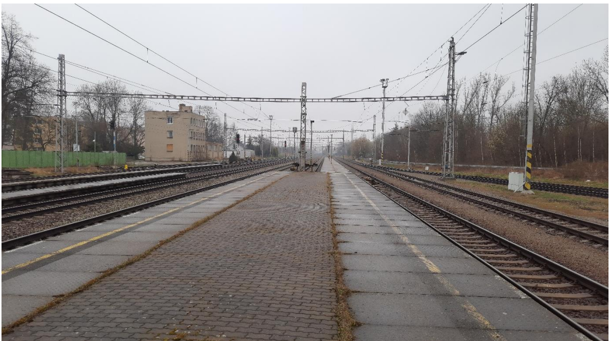
17.4.2021, Žst. Svitavy, pohled na jazykovou část nástupiště 2., směr Česká Třebová
