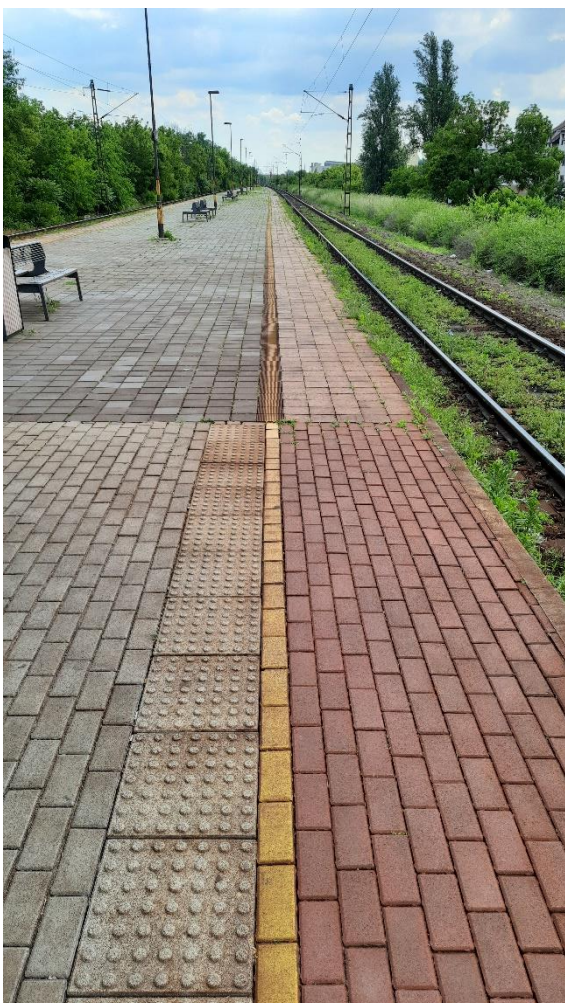
7.6.2021, Budapest-Zugló [Maďarsko], detail hranice aktuální rekonstrukce povrchu nástupiště a další aktuální varianta vyhotovení ochranných pásů na nástupištích na síti MÁV
