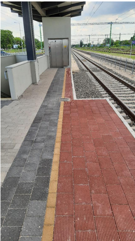
7.6.2021, Budapest-Háros [Maďarsko], nást. 1, jedno z aktuálních vyhotovení ochranných pásů na nástupištích na síti MÁV, viditelný výrazný rozdíl šířky ochranného pásu při různé rychlosti v přilehlé koleji
