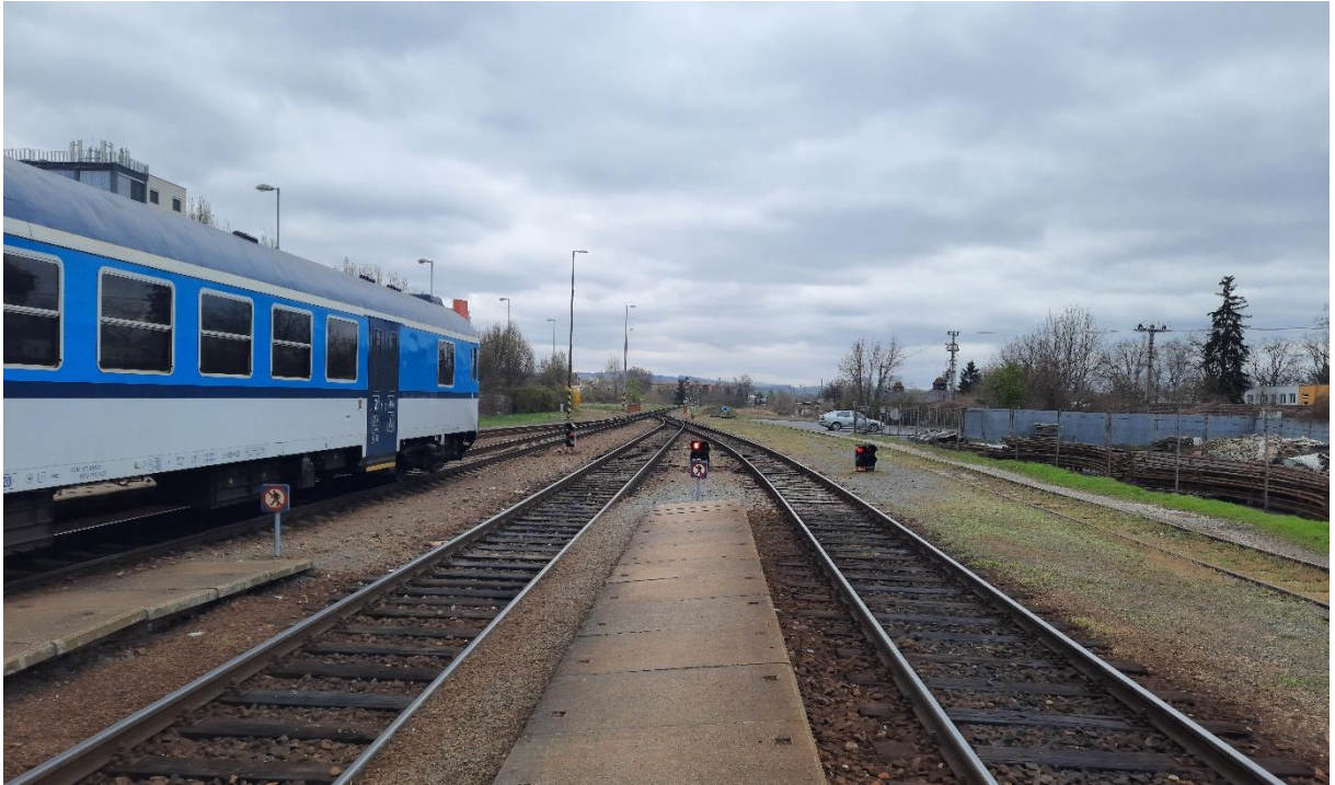
16.4.2021, Žst. Uherské Hradiště, pohled z nástupiště 3. směr Kunovice, vpravo skladiště a volná skládka
