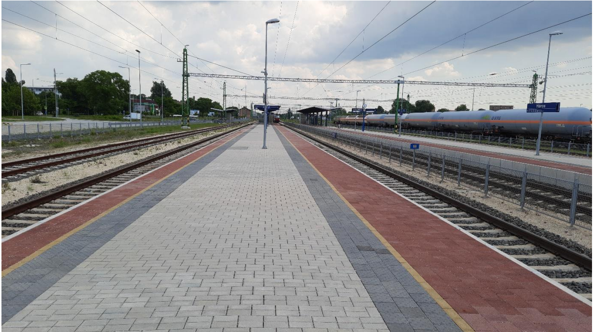
7.6.2021, Budapest-Háros [Maďarsko], nást. 1, jedno z aktuálních vyhotovení ochranných pásů na nástupištích na síti MÁV, viditelný výrazný rozdíl šířky ochranného pásu při různé rychlosti v přilehlé koleji
