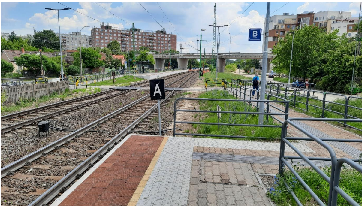
7.6.2021, Budapest-Újpalota [Maďarsko], nást.B, jiné z aktuálních vyhotovení ochranných pásů na nástupištích na síti MÁV a detail nezabezpečeného úrovněového přechodu
