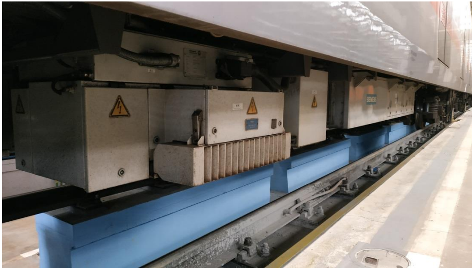
Obr. 36: Kontejnery s trakční výzbrojí vozu M1.1
