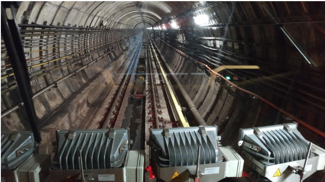
Obr. 50: Měření profilu kolejnic
