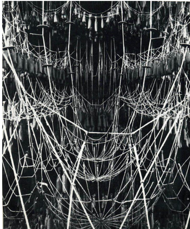
Obr. 12: Gaudího parametrický model kaple Colònia Güell [14]
