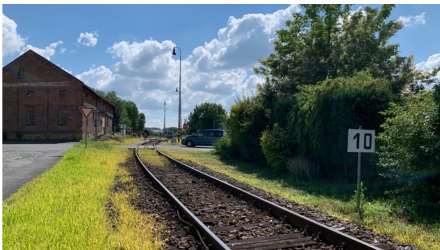
obr. 26 – Přejezd s nevyhovujícími rozhledovými poměry v Uhřetěvesích
