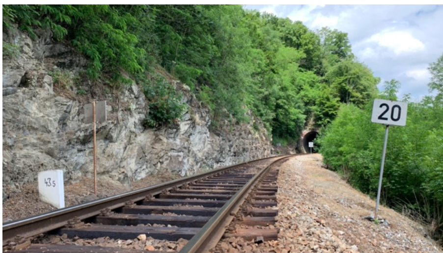
obr. 25 – Omezení u Sázavy kvůli padajícímu kamení
