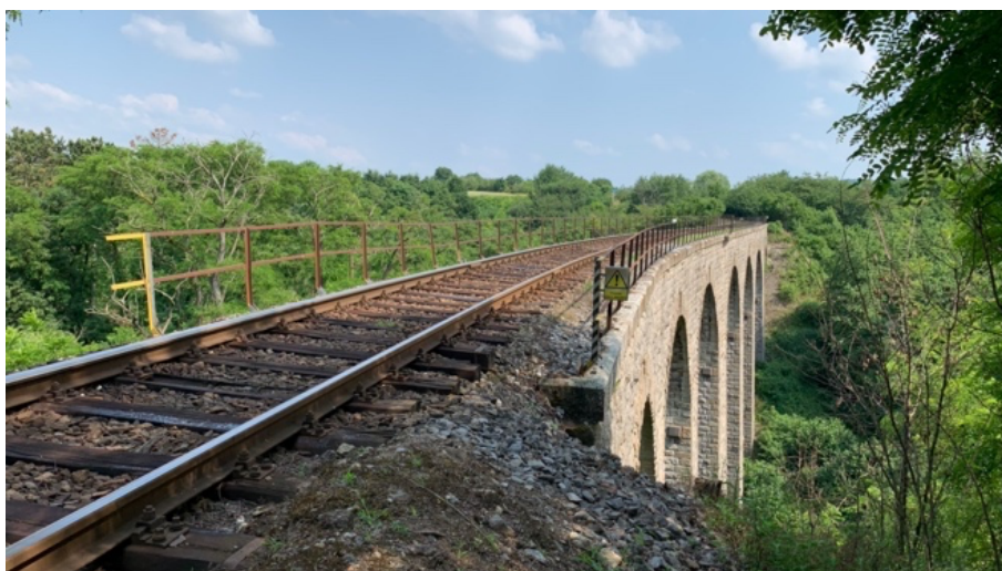
obr. 11 – Viadukt Červené Pečky
