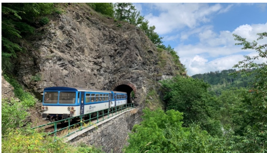
obr. 9 – Samopšecký tunel u Sázavy na trati 212
