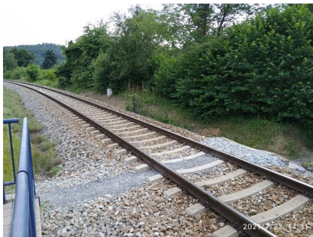
Obrázek 37 – Přístupová stezka přes kolej
