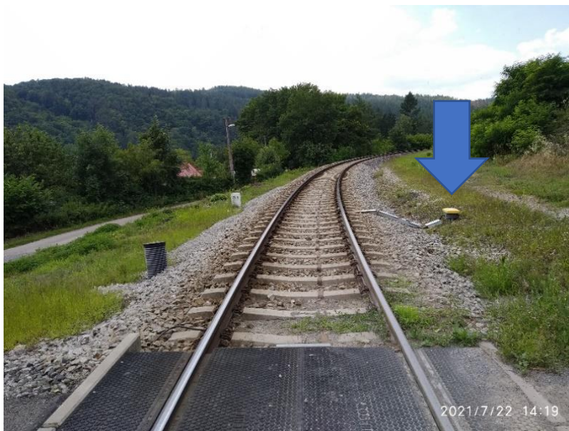
Obrázek 34 - Snímač počítače náprav
