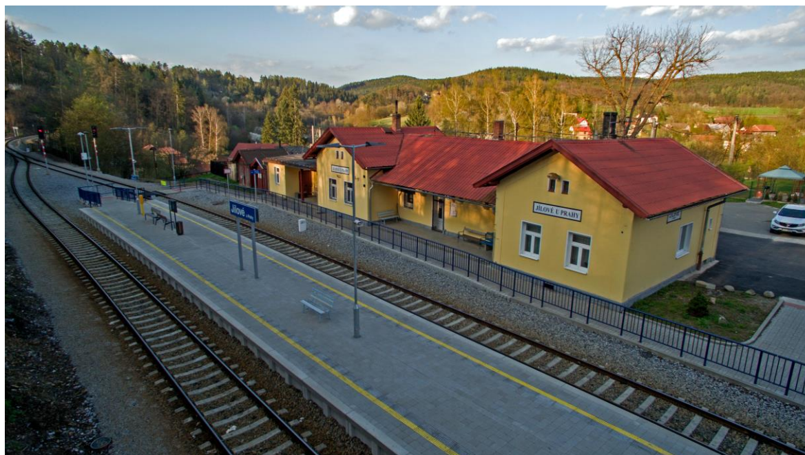
Obrázek 15 - ŽST Jílové u Prahy po rekonstrukci
