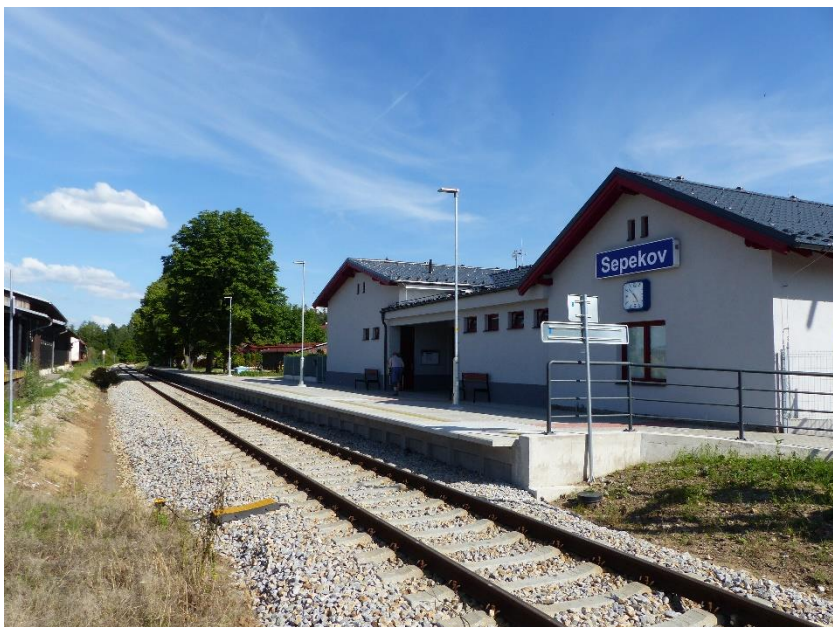
Obrázek 9 – Železniční zastávka Sepekov
