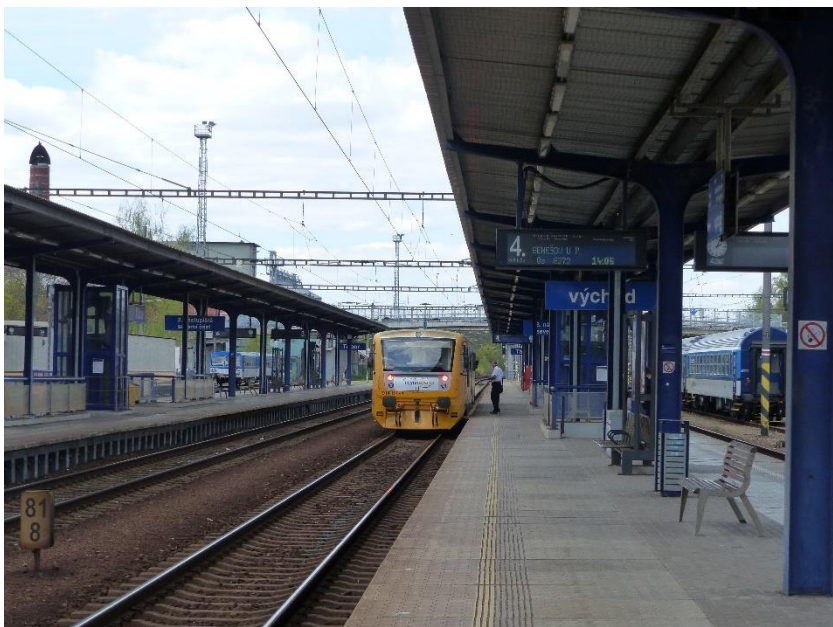
Obrázek 3 – Železniční stanice Tábor ve směru Praha, Písek s motorovou jednotkou řady 814
