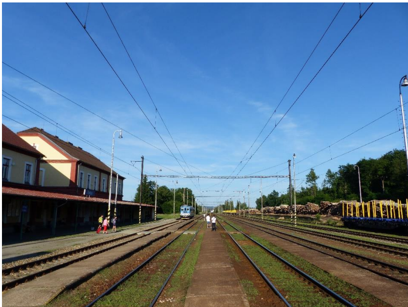
Obrázek 23 – Železniční stanice Ražice ve směru České Budějovice, Písek
