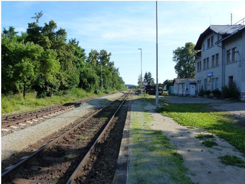
Obrázek 16 – Železniční stanice Vlastec ve směru Písek
