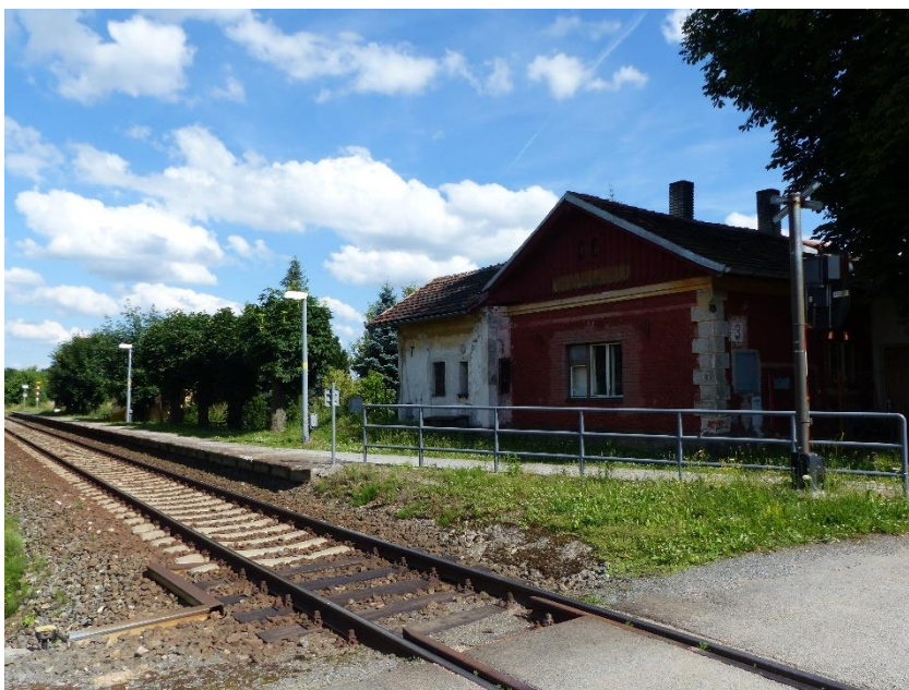
Obrázek 4 – Železniční zastávka Sepekov
