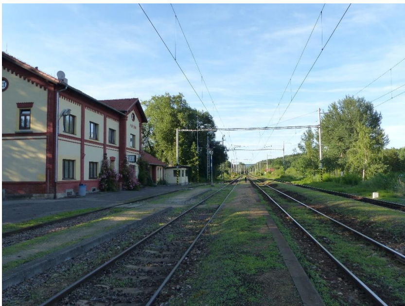
Obrázek 22 – Železniční stanice Putim ve směru Písek
