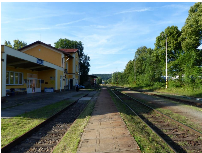
Obrázek 19 – Železniční stanice Písek město ve směru Milevsko
