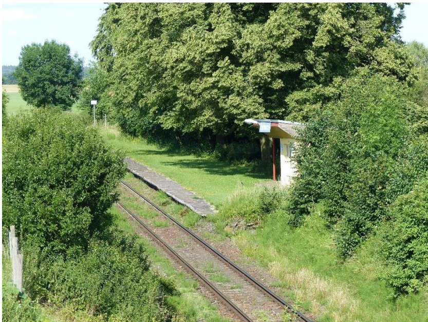
Obrázek 13 – Železniční zastávka Stehlovice ve směru Milevsko
