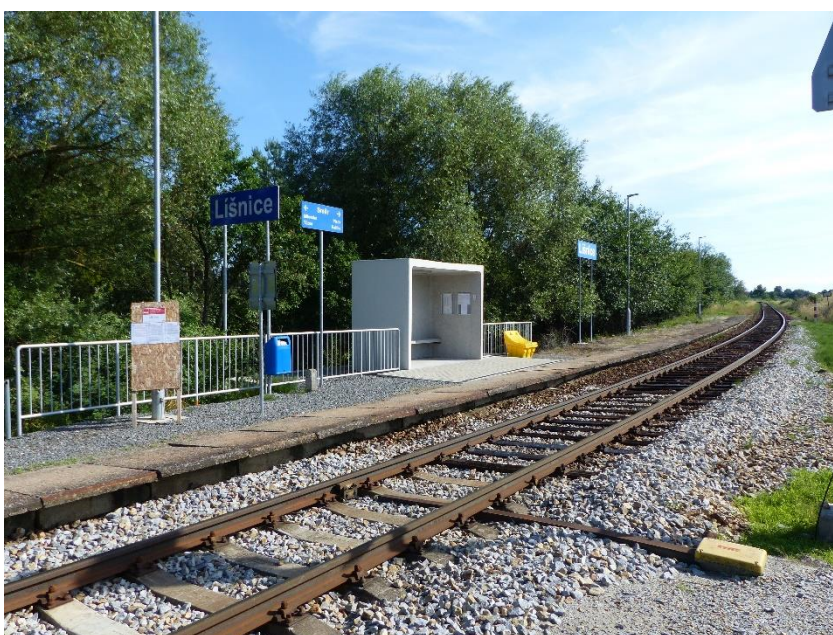
Obrázek 11 – Železniční zastávka Líšnice
