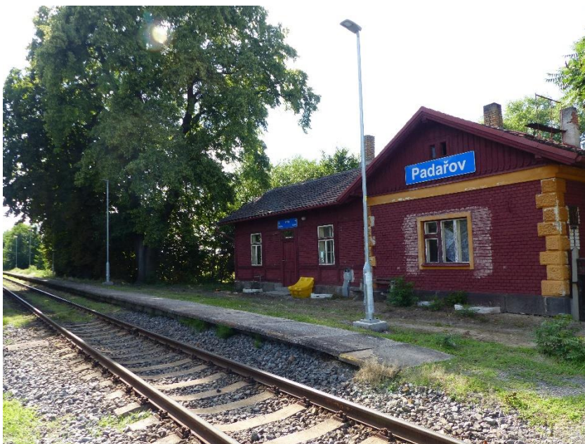
Obrázek 7 – Železniční zastávka Padařov
