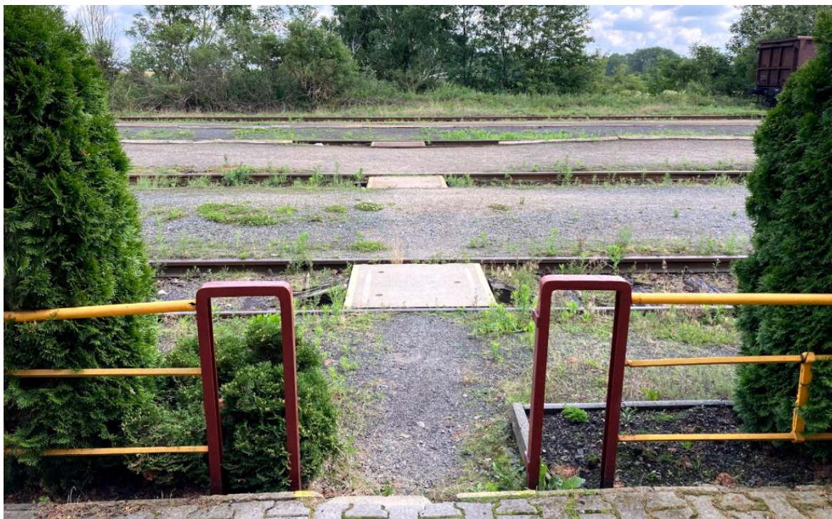
Obrázek 15 - Přístup k nástupištím přes panelový přechod v km 156,730 (zdroj: [Adam Hoffmann, 10.7.2021])
