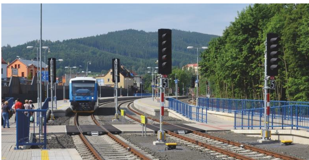
Obrázek 14 - Příklad provedení nástupišť v žst. Tanvald (rekonstr. r. 2015) dle aktuálních standardů normy ČSN 73 4959 (zdroj: [77])
