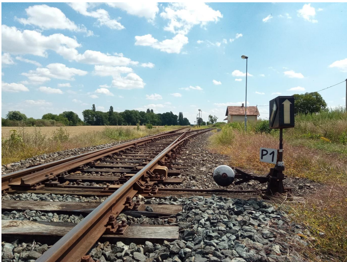
Obrázek 24: Vlečková výhybka P1 v Poleradech nad Labem
