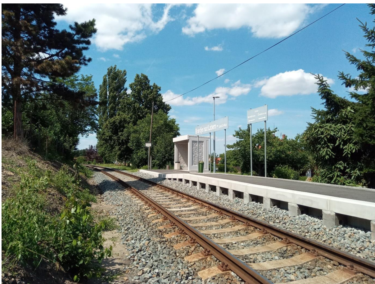
Obrázek 20: Přístřešek a část nástupiště v zastávce Brandýs nad Labem zastávka
