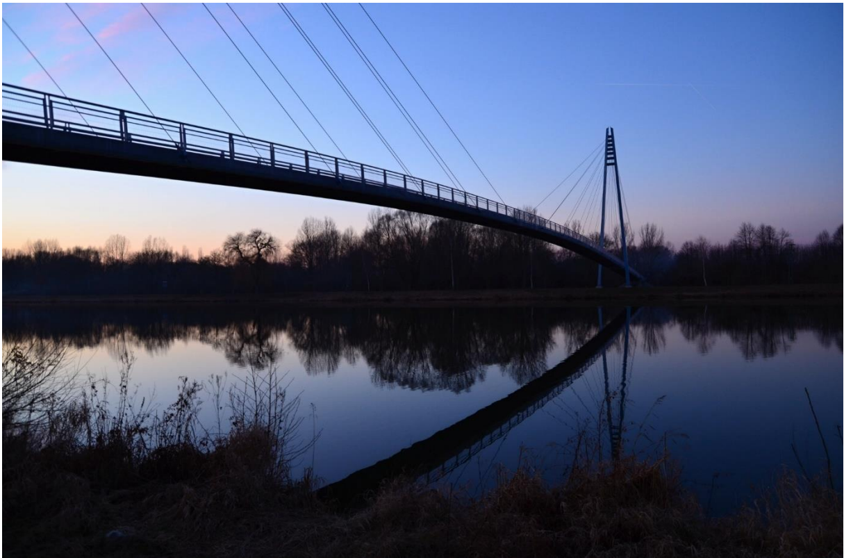
Obrázek 2: Lávka přes Labe v Čelákovících [32]
