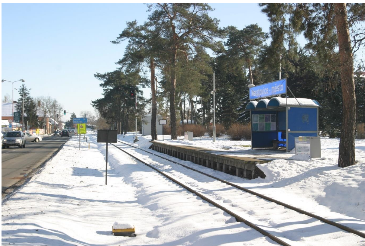
Obrázek 28: Zastávka Neratovice město s odjezdovým návěstidlem S 10
