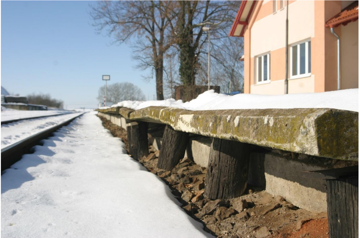
Obrázek 34: Konstrukce nástupiště v Kostelci n. L.
