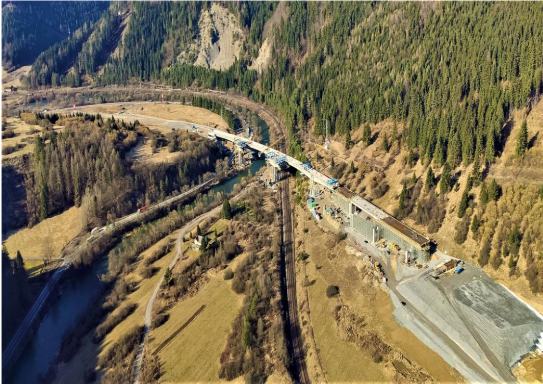
Príloha 2. Letecký pohľad na časť diaľničného úseku D1 Hubová Ivachnová (archív NDS)
