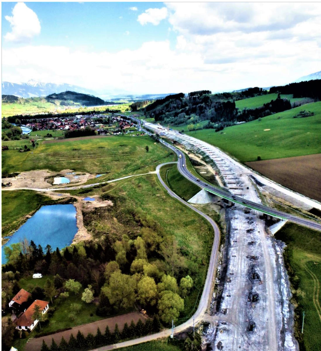
Príloha 1. Letecký záber na časť diaľničného úseku. (archív NDS 10.8.2021)
