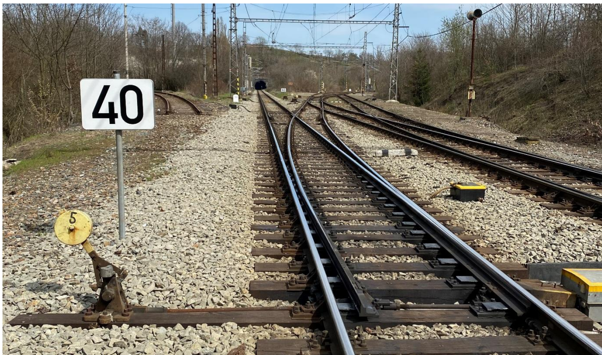
Obrázek 9: Pohled na začátek běchovického zhlaví
