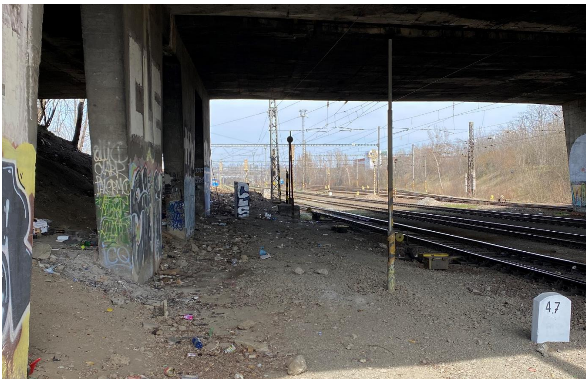
Obrázek 22: Prostor pod mostem v km 4,687, křížení s ulicí Černokostelecká
