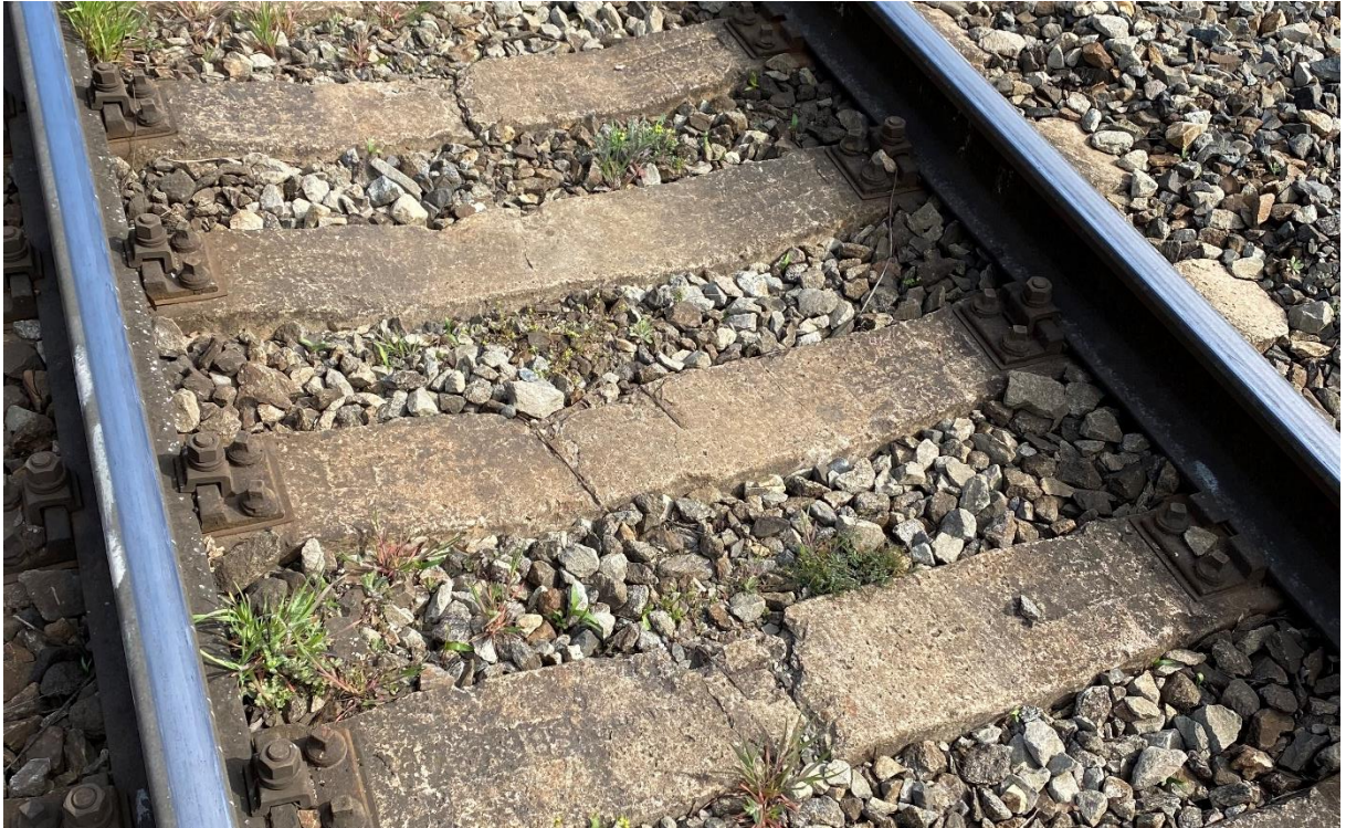
Obrázek 19: Poškozené pražce v koleji č. 2 Zdroj: vlastní fotoarchiv, foceno 11.4.2021
