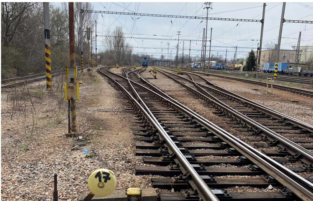
Obrázek 8: Pohled předávací koleje vleček, za zády vlečka „Vlečka Teplárna Malešice Praha“
