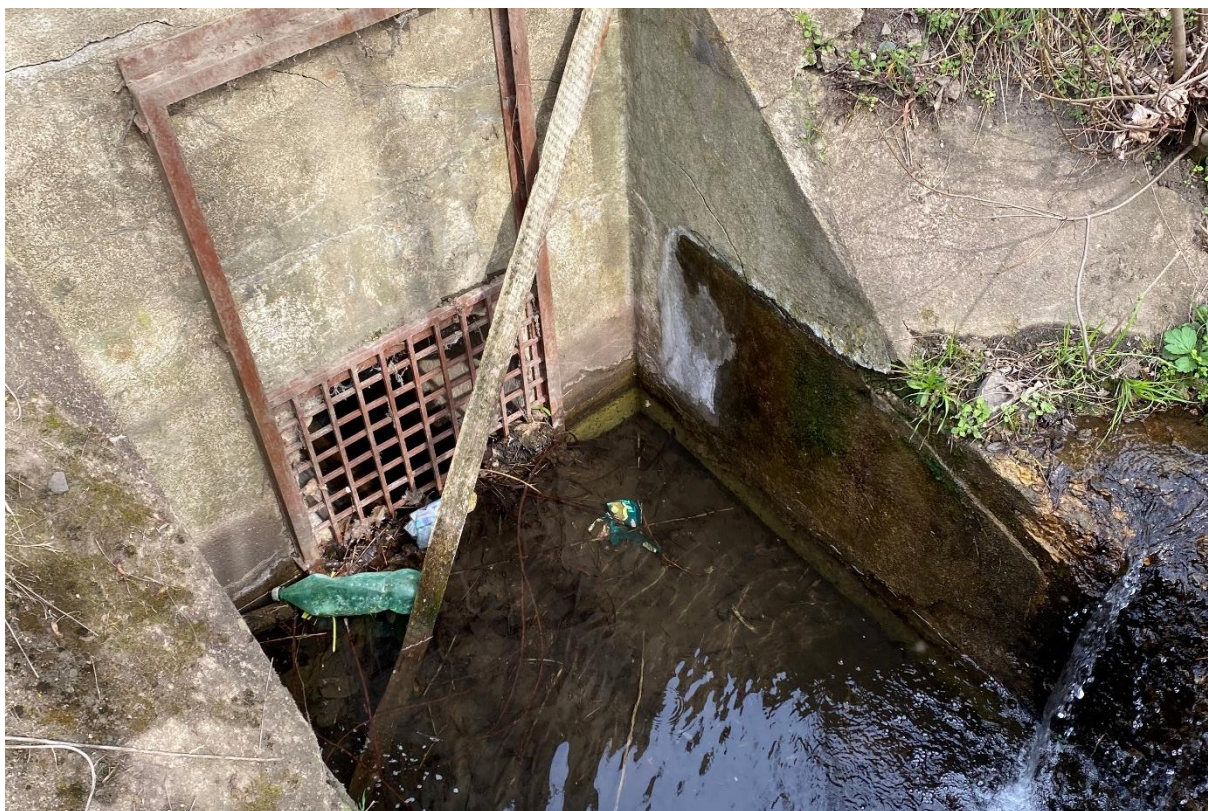
Obrázek 12: Trubní propustek ev. km 5,838, záhlaví směr Praha-Běchovice
