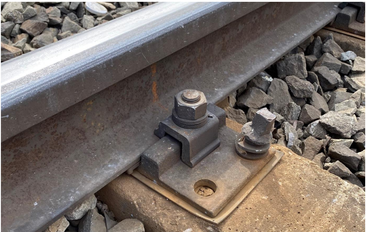
Obrázek 20: Chybějící vrtule upevnění Zdroj: vlastní fotoarchiv, foceno 11.4.2021
