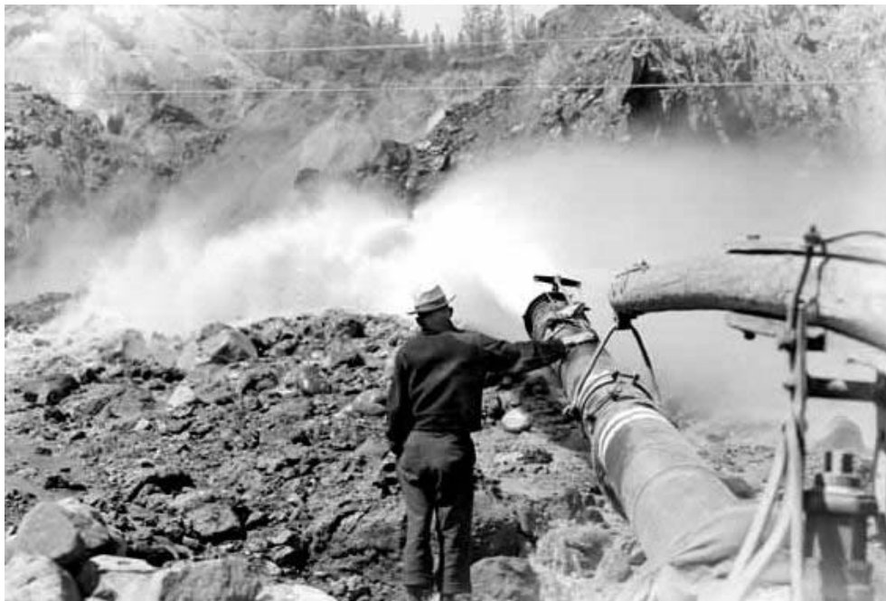
Obr. 3.1: Využívání hydromonitorů při těžbě v oblasti Trinity County [13]
