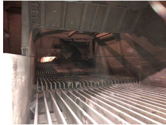
Obr. 44.: Osobní prohlídka roštu – pohled na rošty
