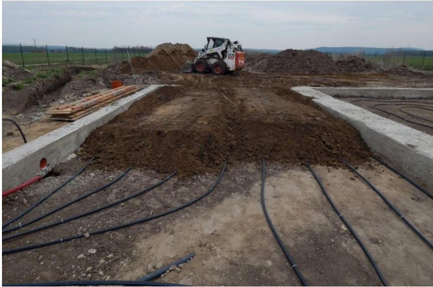
Obr. 3: Instalace plošného zemního kolektoru pod objektem [8]
