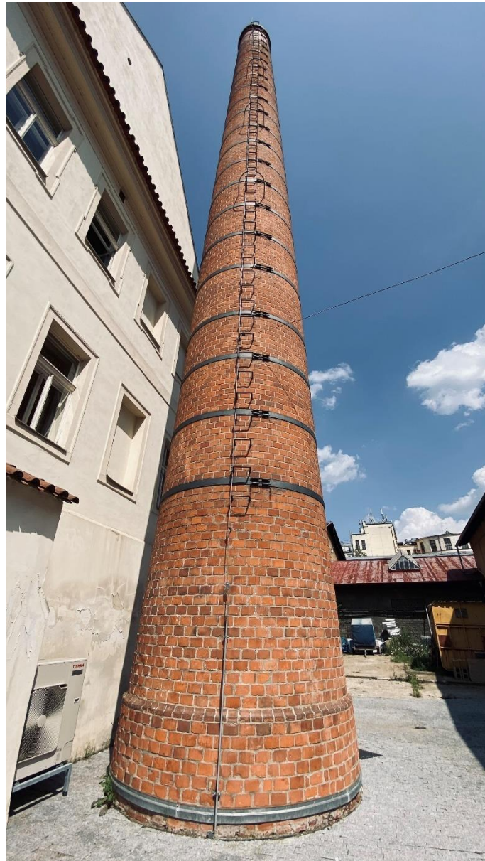
Obr. 28.: Fotografie komína v areálu ČVUT na Karlově náměstí
