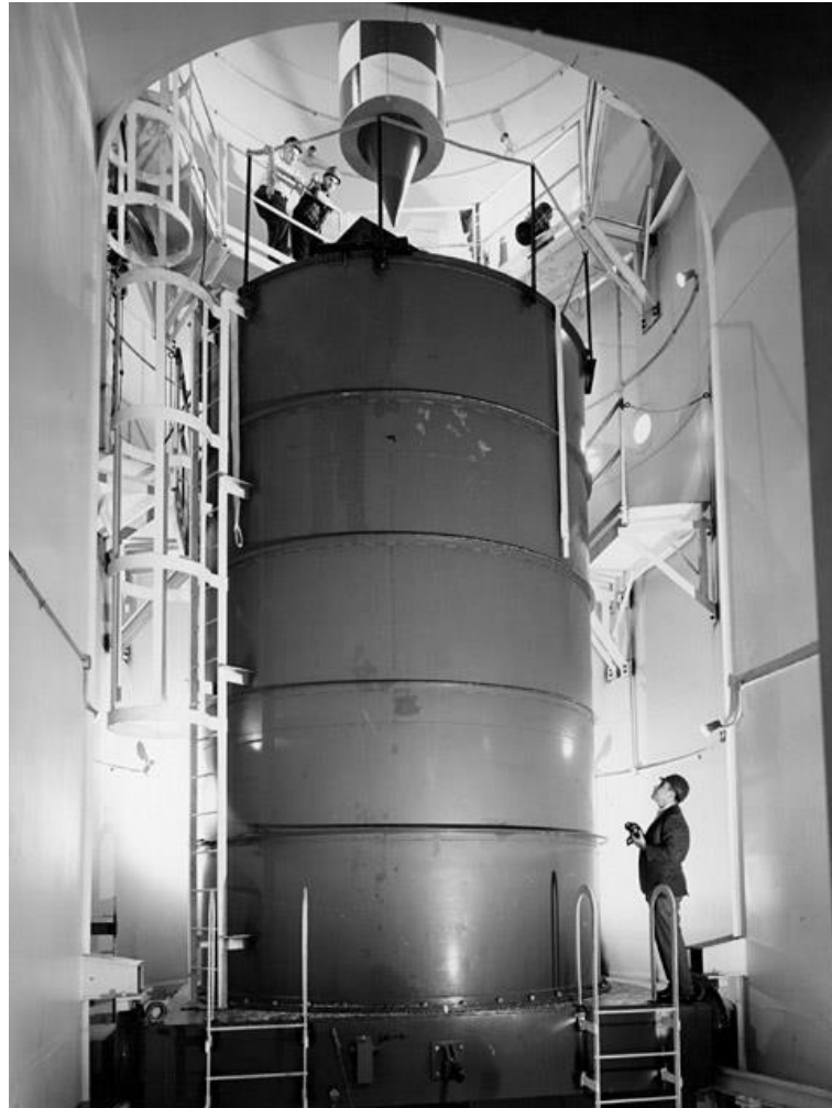
Obr. 11.: Zpomalovací nádoba ve spodní části věže [26]
