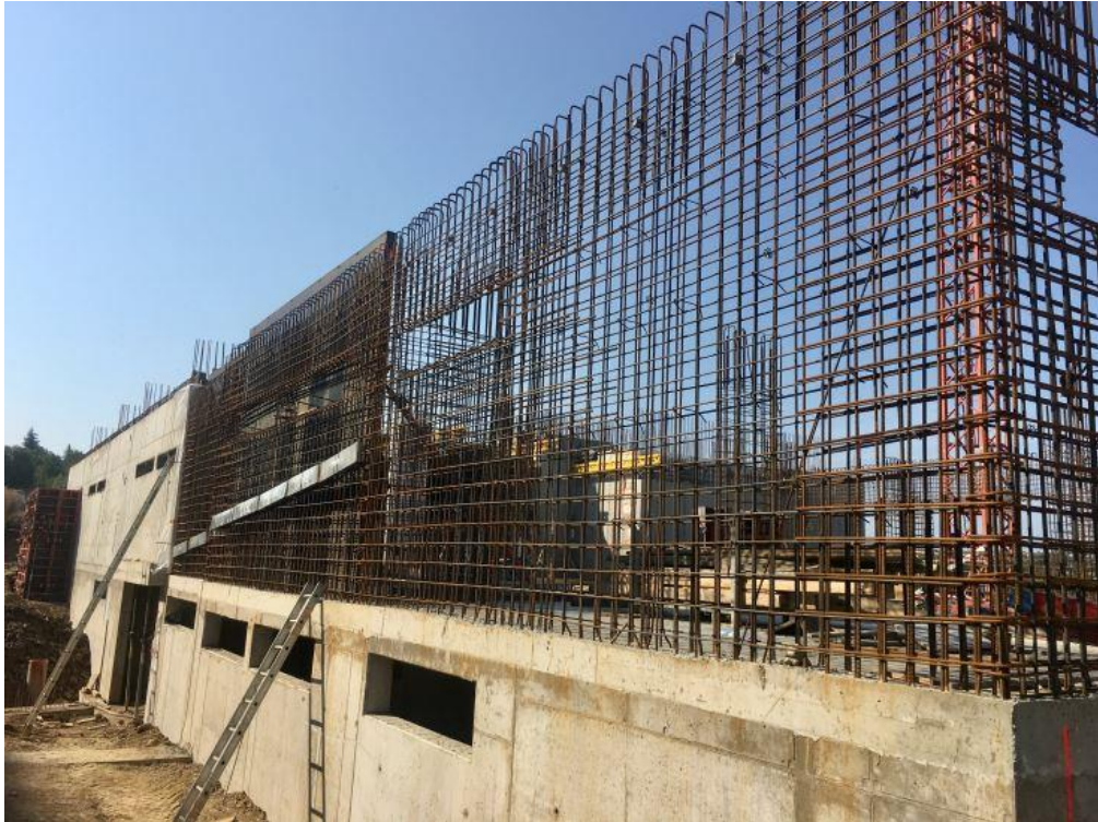
Obrázek 5 - Vznik monolitické konstrukce, projekt Kaskády Barrandov [15]
