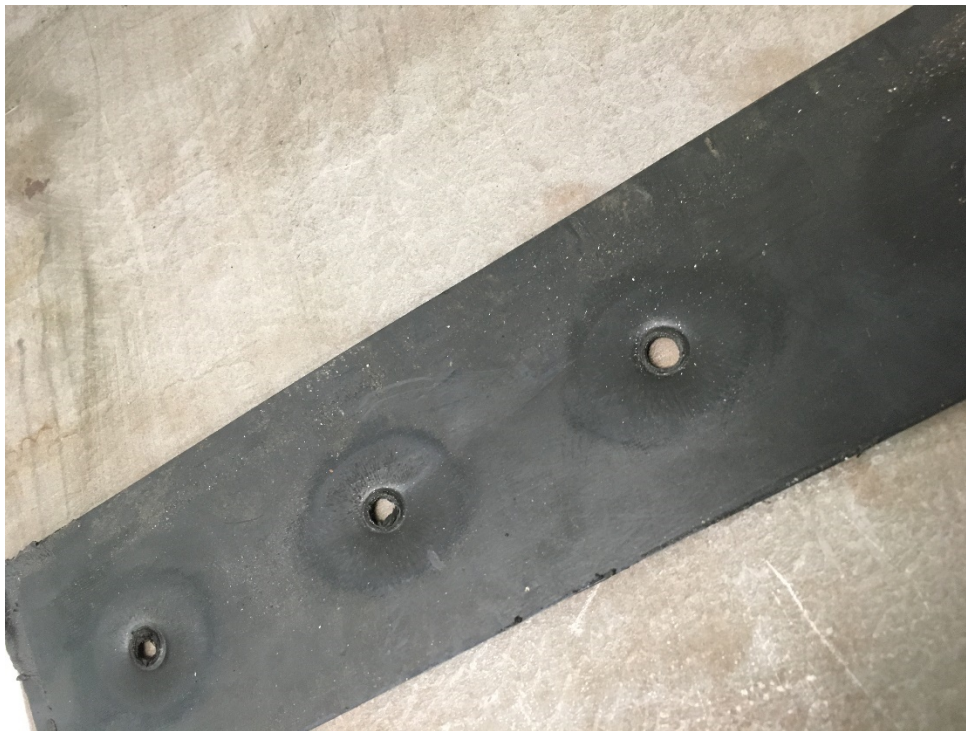
Obrázek 60: Silikonové těsnění po demontáži přípravku
