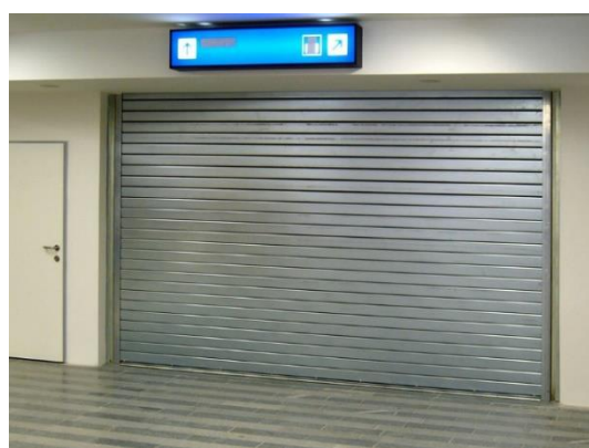
Obr. 3: Ocelový svislý roletový požární uzávěr [6]
