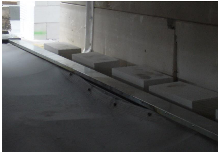
Obr. 32: Vytržení ložisek z vodítka
