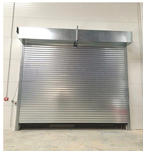
Obr. 12: Ocelový svislý uzávěr se zkrápěním [10]
