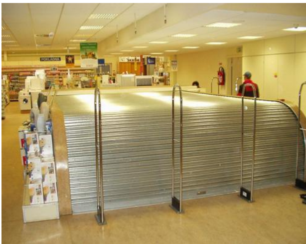
Obr. 4: Ocelový horizontální požární uzávěr [7]
