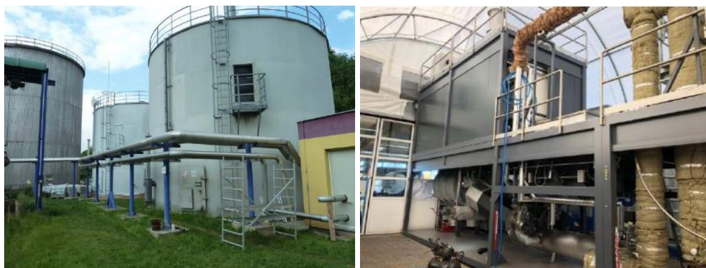
Obrázek 6 - ČOV Trutnov Bohuslavice – vlevo plynojem, vpravo pyrolýza [7]
