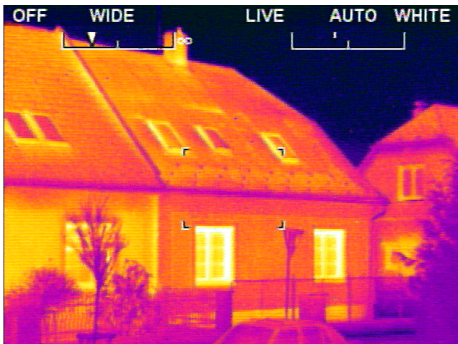
Obr. 2.5: Termovizní měření rodinného domu, zdroj: autor
