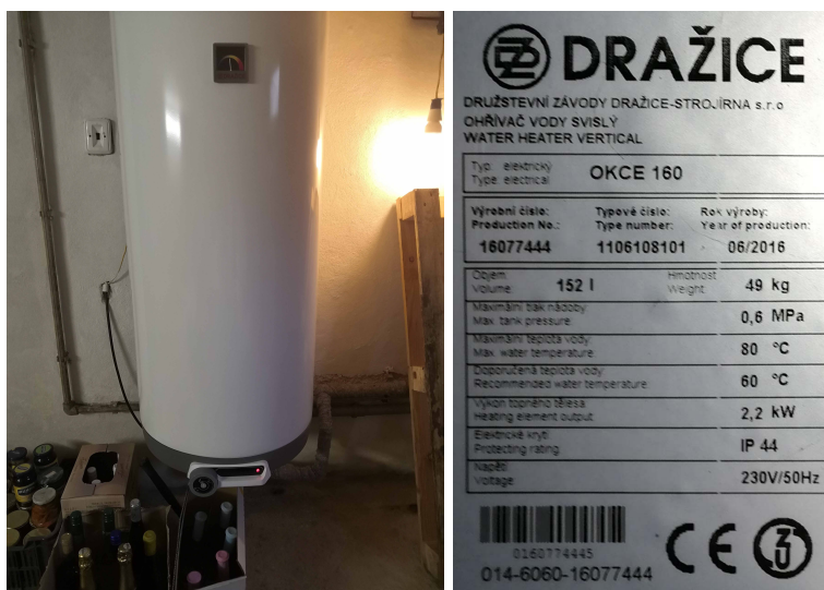
Obr. 2.3: Elektrický zásobníkový ohřívač vody OKCE 160, zdroj: autor
