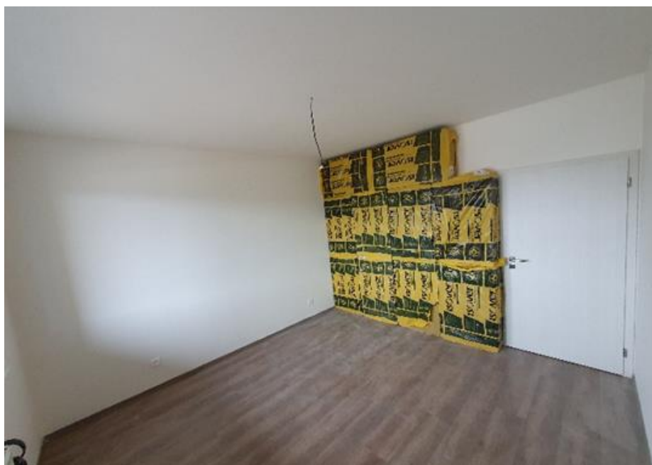
Obr. 17 Volně položené balíky minerální vaty na boční stěně přijímací místnosti
