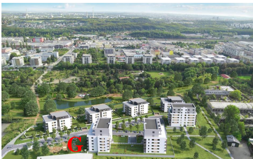
Obr. 11 Pohled na objekt G ve kterém bylo provedeno měření
