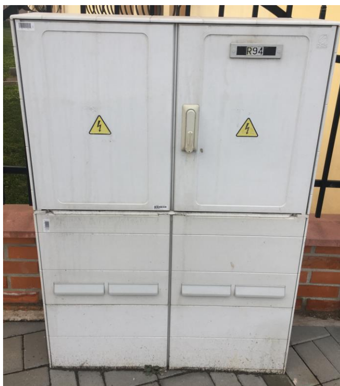
Obr. 2-4: Celoplastová přípojková skříň
