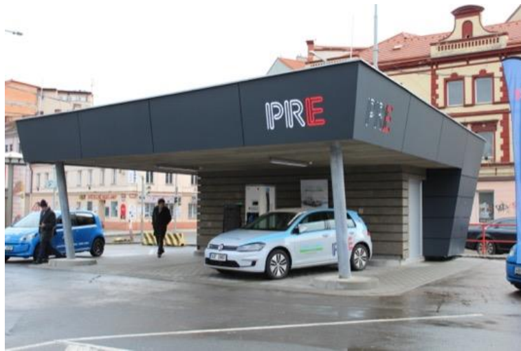
Obrázek č.5 - Dobíjecí stanice Praha - Holešovice [7]
