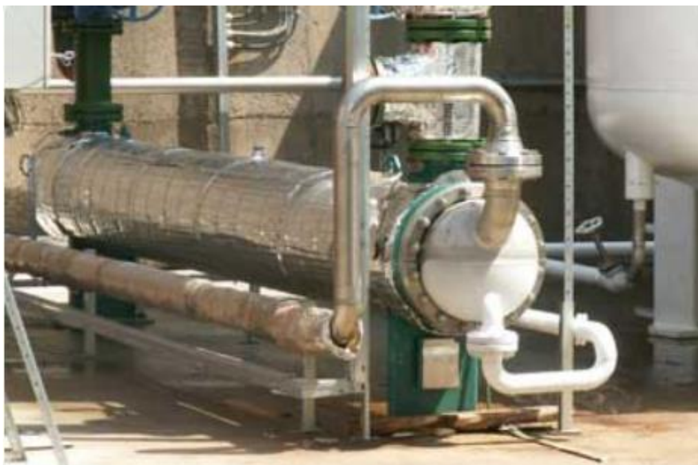
Obrázek 41 Cirkulační vypařovák – převzato z [32]
