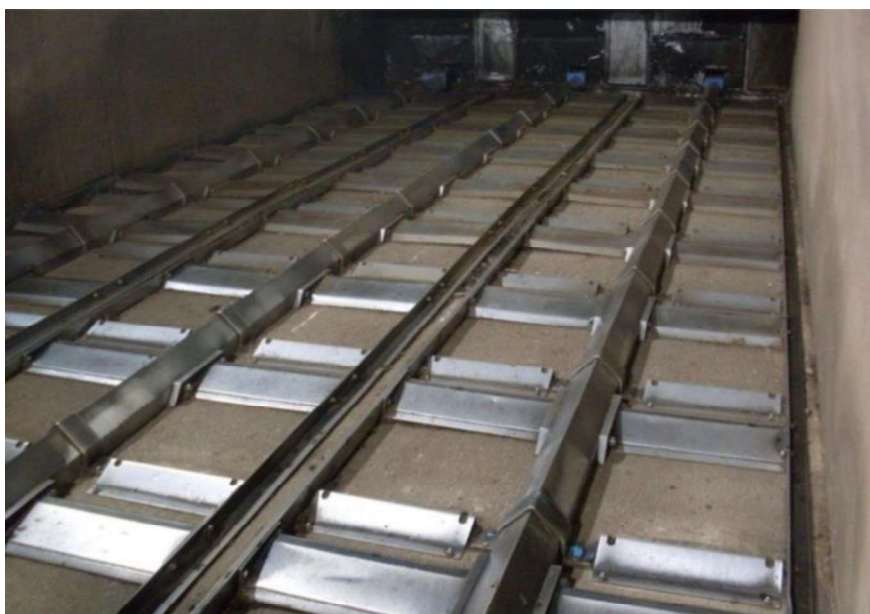
Obrázek 31: Posuvná podlaha na štěpku – Teplárna Mydlovary, 9 MWt [29]
