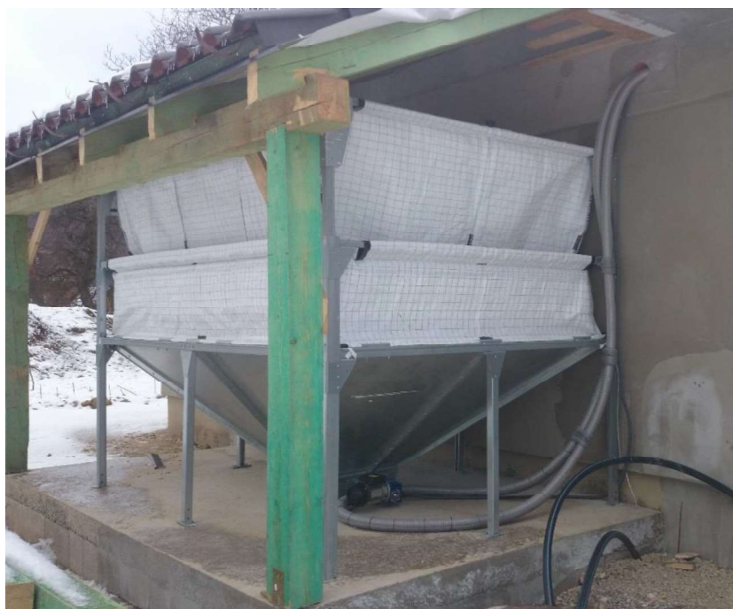
Obrázek 28: Textilní silo s pneumatickou dopravou pelet do kotle [31]
