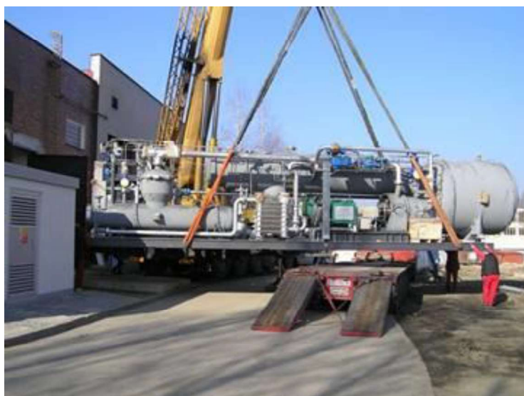
Obrázek 29: Instalace ORC modulu – Teplárna Trhové Sviny, 0,6 MWe, 2,8 MWt [59]
